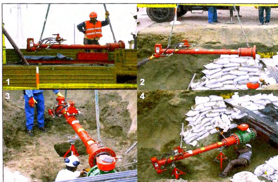
Figura 3.9 – Instalación de la Válvula Hot-Tap
