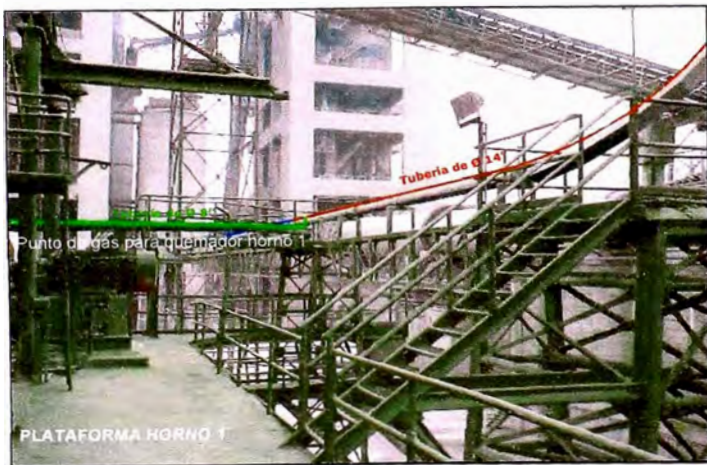
Figura 2– Tuberías Horno I
