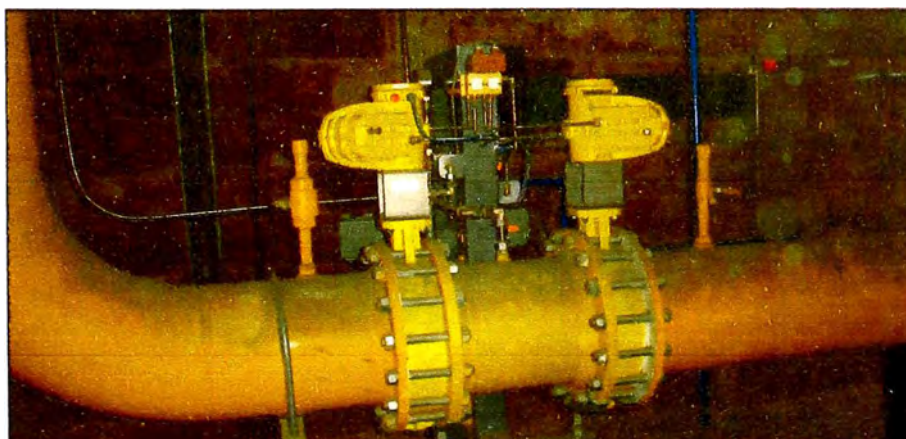
Figura 3.41– Sistema Shut-Off Cierre Rápido
