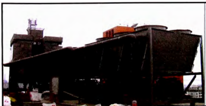
Figura 1.- Chiller Enfriados por Aire
