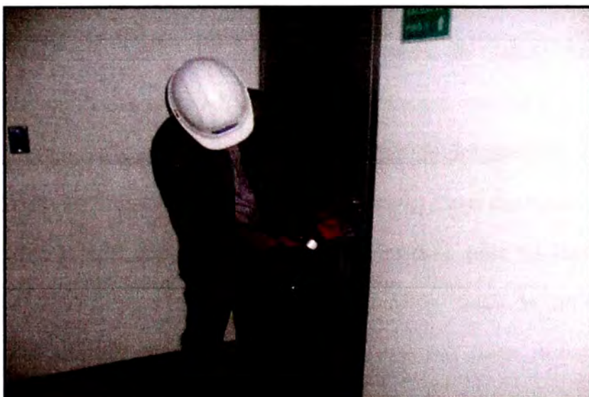
Fig. 4 Prueba de apertura de puerta de escape
