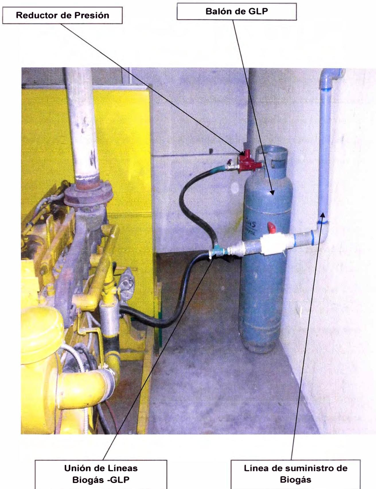
**Figura 4.3. Adaptación de Sistema con GLP**
