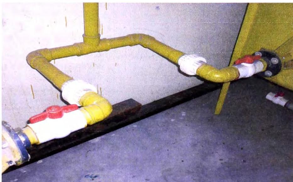
**Figura 3.7. Paso del Biogás desde los Filtros hacia el Grupo Electrónico**
