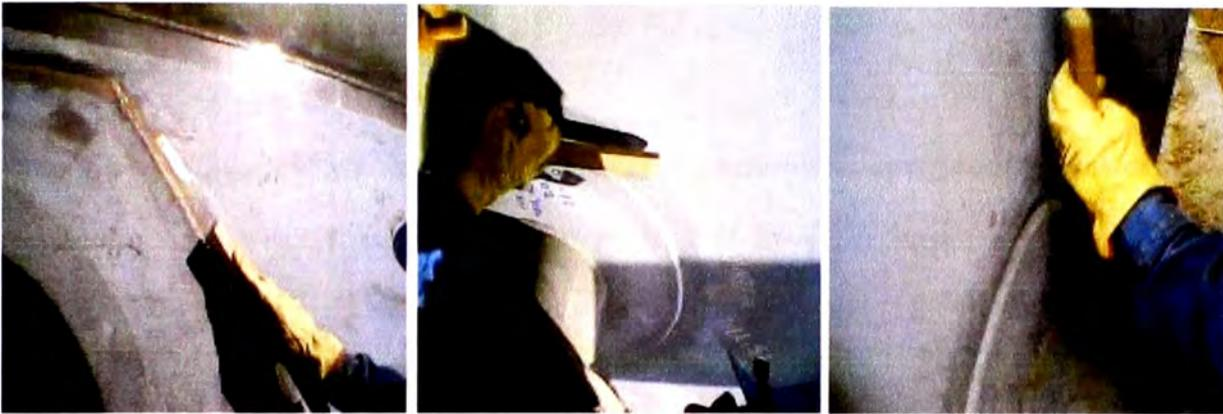
Figura 4.11: Proceso de limpieza en los cordones de soldadura en todo el soldeo de la plancha de refuerzo
