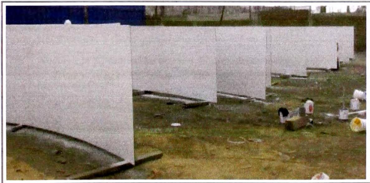
Figura 3.5: Verificación del espesor de pintura del Macropxy 646, para el interior del tanque, 6mils y para el exterior del tanque pintura del Zinc Clad 60, 4mils.
