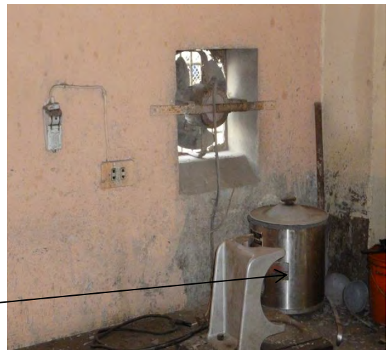
Materiales dañinos a la salud, mala ventilación: Olla eléctrica de refrendado (azufre y bentonita)
