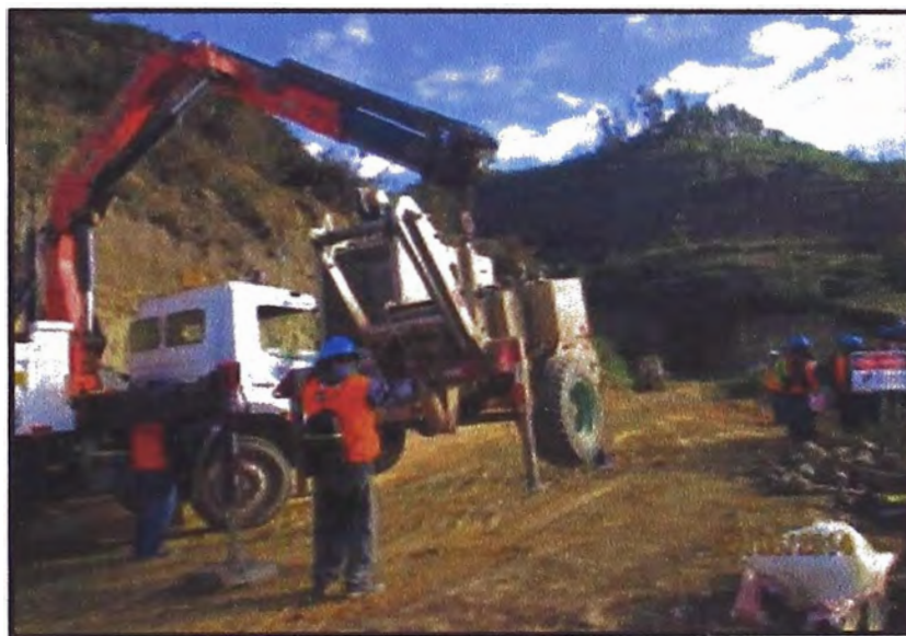
Figura 3.20: Traslado del winche al punto de trabajo
