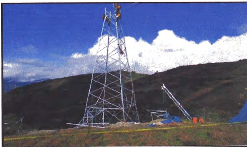
Figura 3.16: Izaje de estructura de torre
