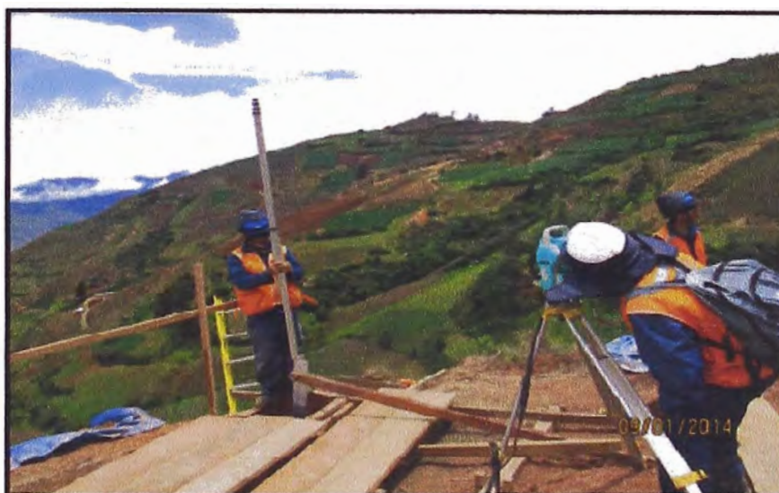
Figura 3.9: Nivelación de stub
