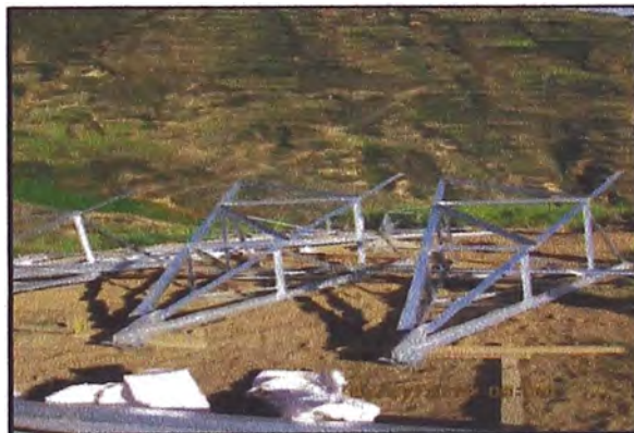
Figura 3.15: Ensamblaje de torres
