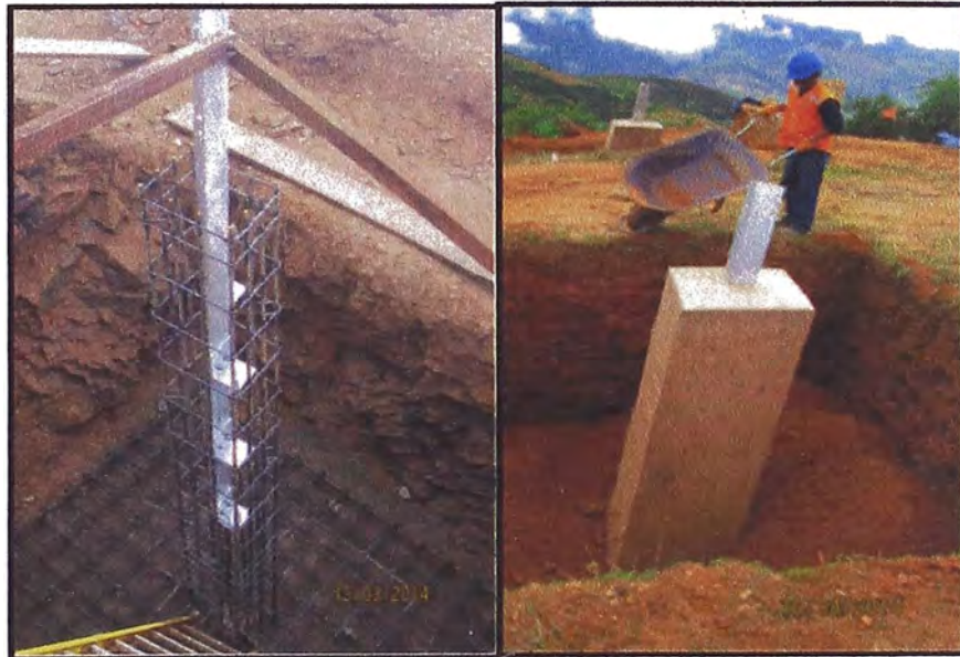
Figura 2.2: Cimentación tipo zapata
