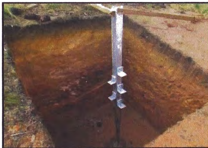
Figura 2.8: Stub de una torre
