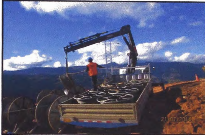
Figura 3.22: Traslado y descarga de boninas
