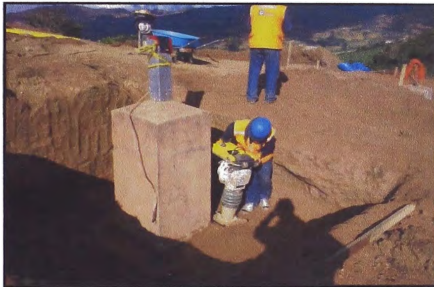
Figura 3.13: Trabajos de compactación
