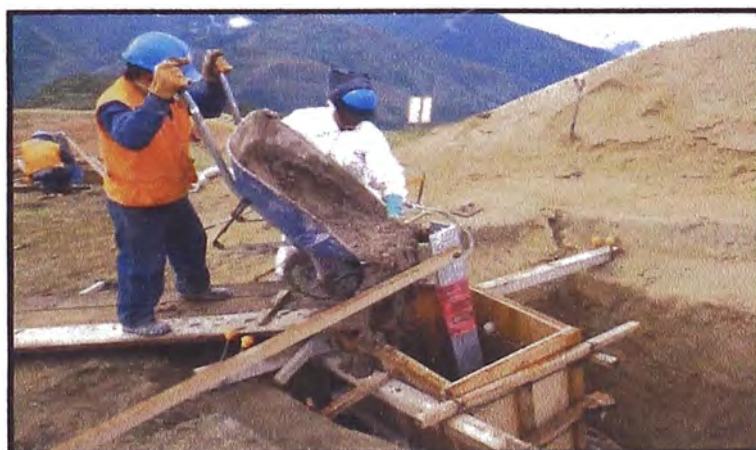
Figura 3.12: Vaciado de concreto en pedestal
