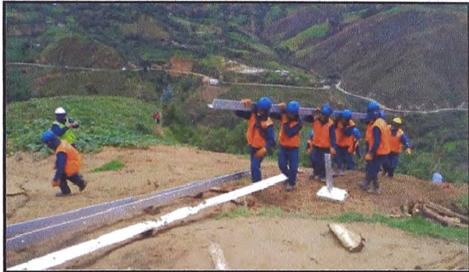
Figura 3.14: Transporte manual de perfiles
