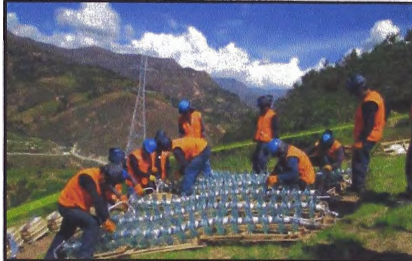
Figura 3.18: Transporte y armado de aisladores.
