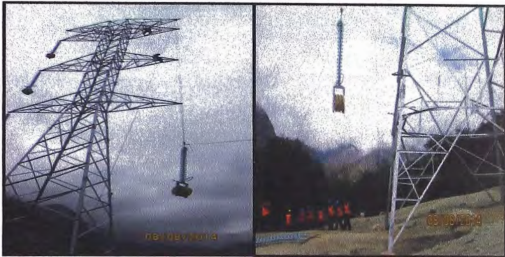
Figura 3.19: Colocación de aisladores y poleas
