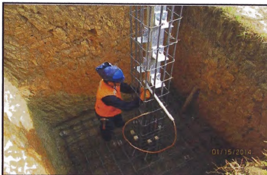
Figura 3.8: Instalación de acero
