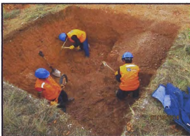
Figura 3.7: Excavación de hoyo para cimentación
