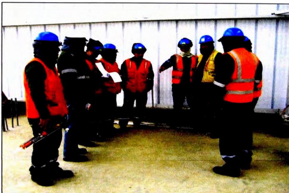
Fig. 3.46 Reunión previa al sellado final del techo. Uso de sikaflex
