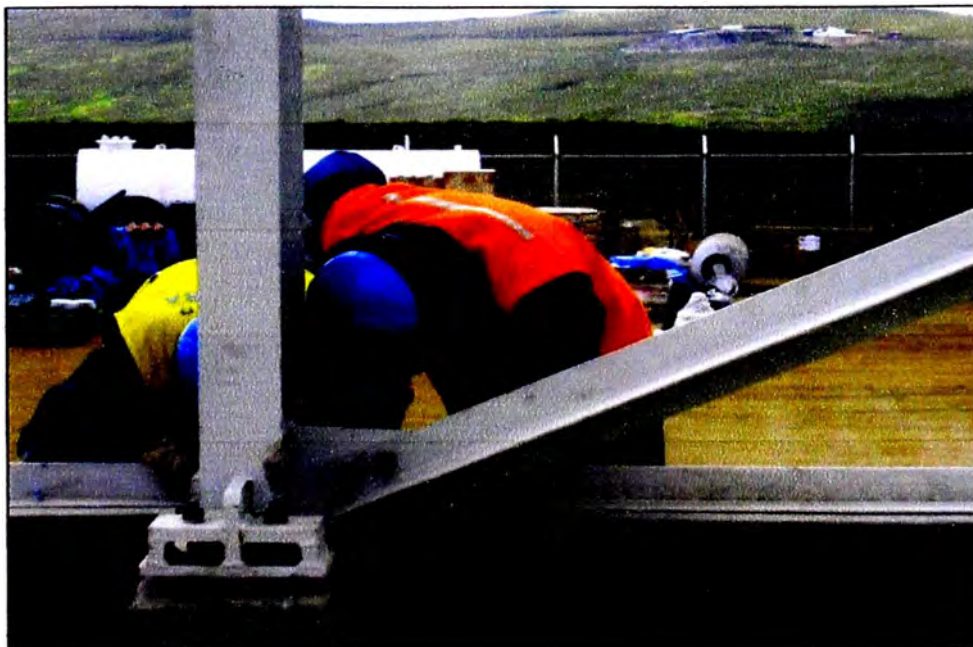
Fig. 3.43 Ángulos en sardinel como soportes de cerramientos laterales
