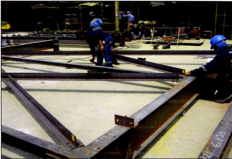
Fig. 3.22 Pre-armado. Amarres de pórticos y arriostramiento lateral
