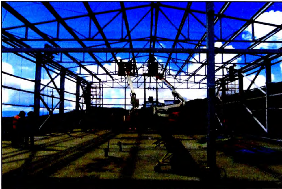
Fig. 3.38 Instalación de arriostramientos de techo y templadores
