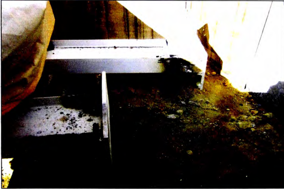
Fig. 3.28 Modificación de silletas de anclaje de las columnas
