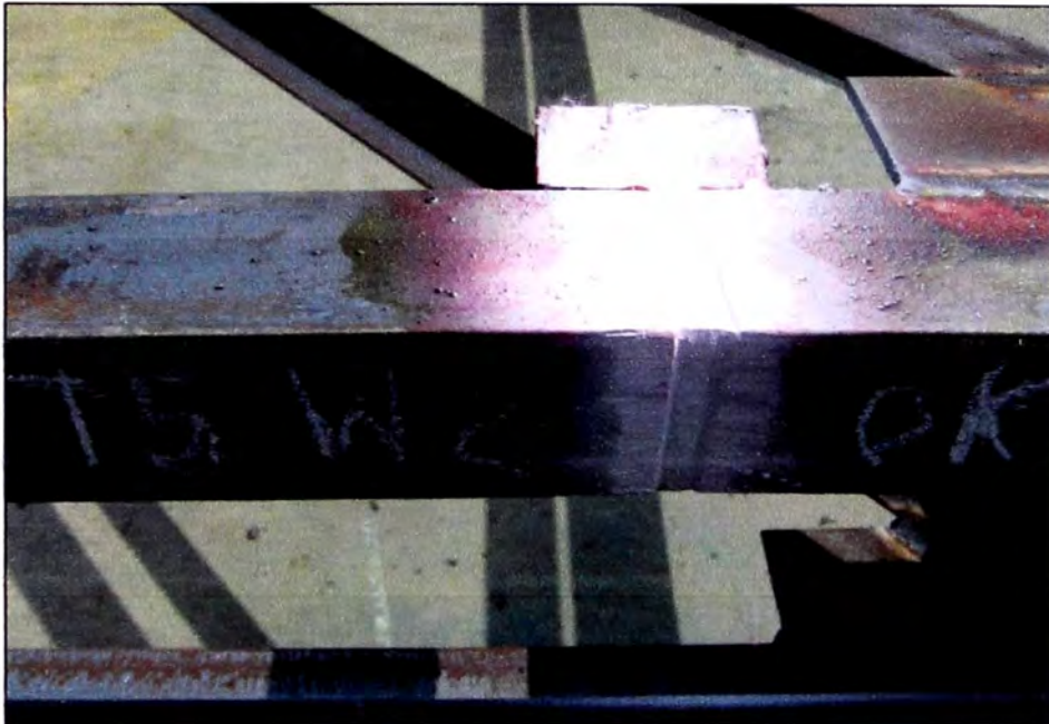
Fig. 3.12 Inspección de pase raíz en tijeral T-5, soldador w2.
