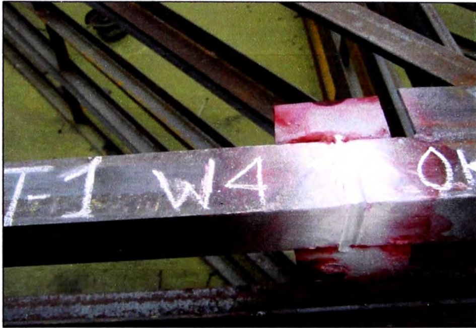
Fig. 3.8 Control de soldadura en tijeral T-1, soldador w4
