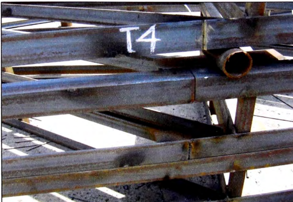
Fig. 3.7 Armado de tijerales uno sobre otro
