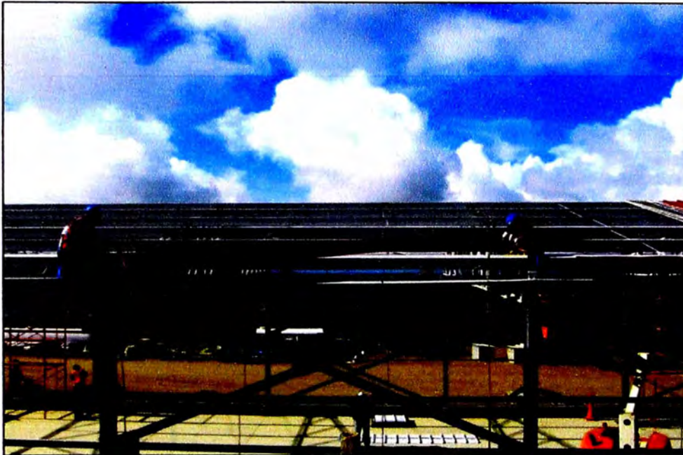
Fig. 3.40 Izaje de coberturas de techo
