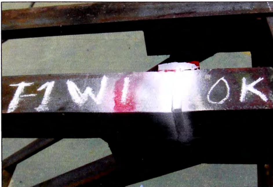
Fig. 3.9 Control de soldadura en tijeral T-1, soldador w1
