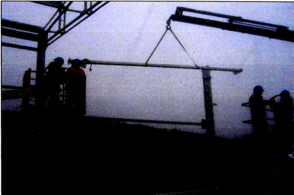
Fig. 3.32 Montaje de arriostre lateral
