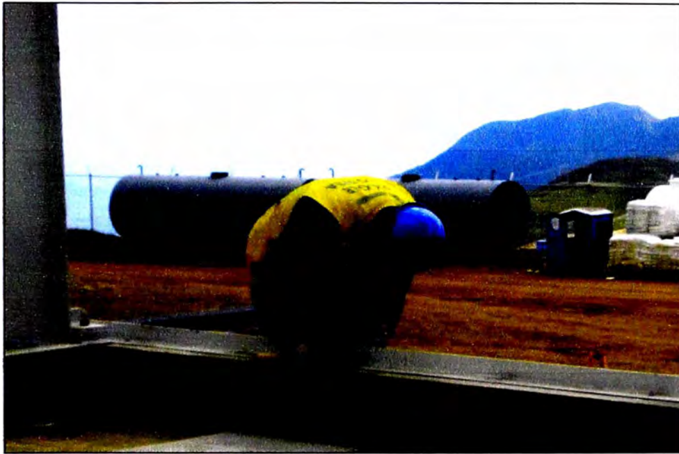
Fig. 3.42 Montaje de L3"x3"x1/4" sobre sardinel. Pernos de expansión
