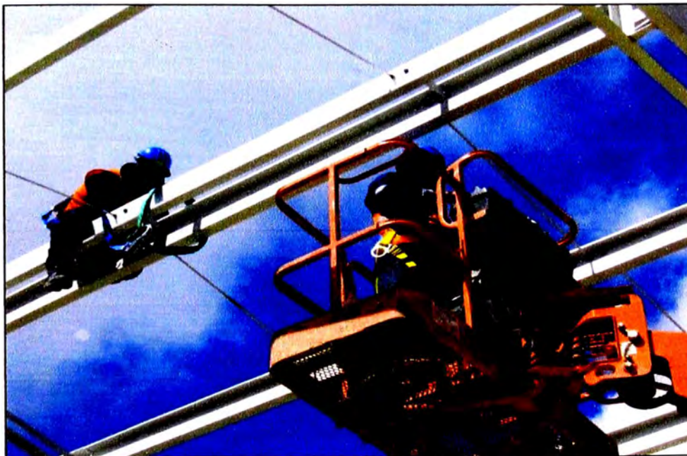
Fig. 3.39 Instalación de templadores de correas de techo
