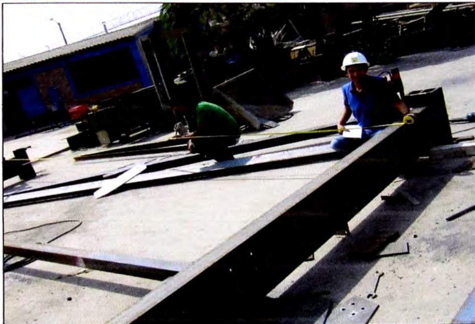
Fig. 3.23 Control de pre-armado. Distancia entre ejes de columnas
