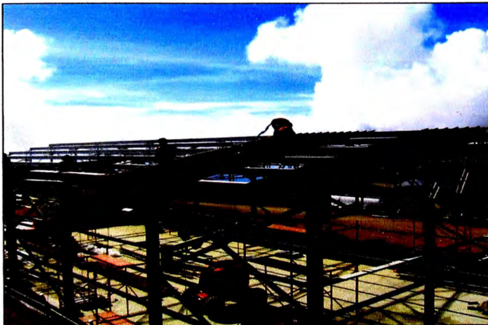
Fig. 3.41 Instalación de coberturas de techo e instalación de canaletas
