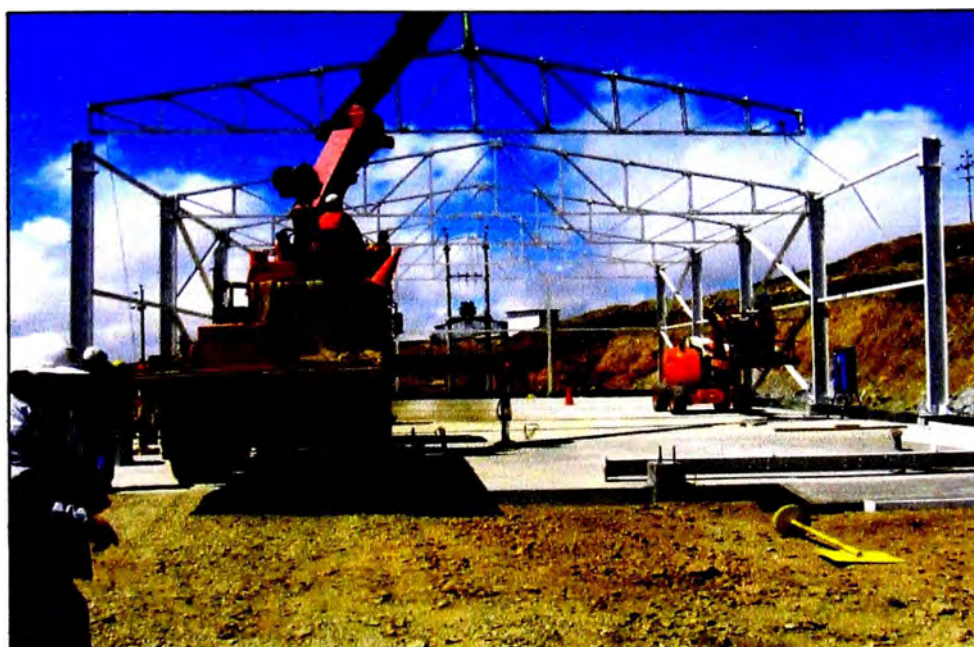
Fig. 3.35 Montaje del tijeral N° 5
