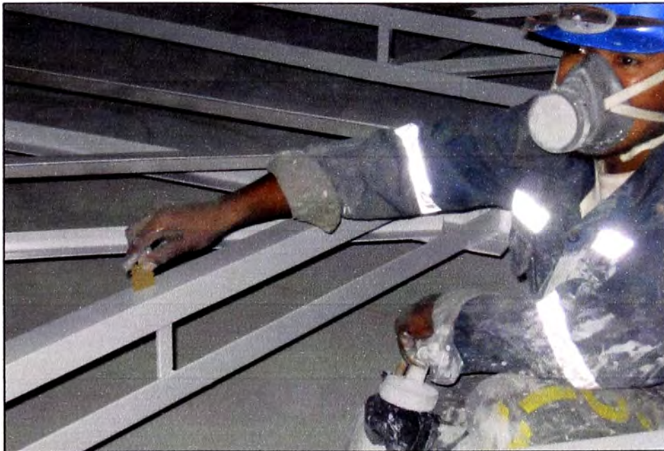
Fig. 3.27 Control de pintura. Espesor de pintura en húmedo
