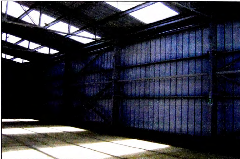
Fig. 4.1 Entrega del Almacén General - Parte interior
