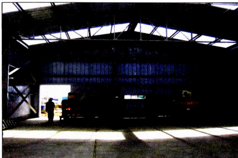
Fig. 3.47 Inspección del edificio industrial, previo a la entrega
