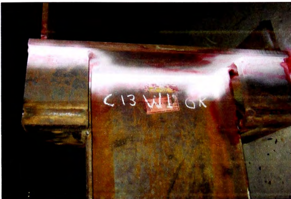
Fig. 3.21 Inspección de pase acabado en columnas C-13, soldador w1.
