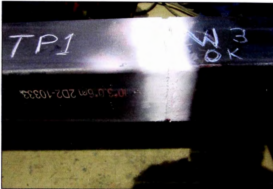
Fig. 3.14 In pección de pase raíz en amarre pórticos TP-1, soldador w3.
