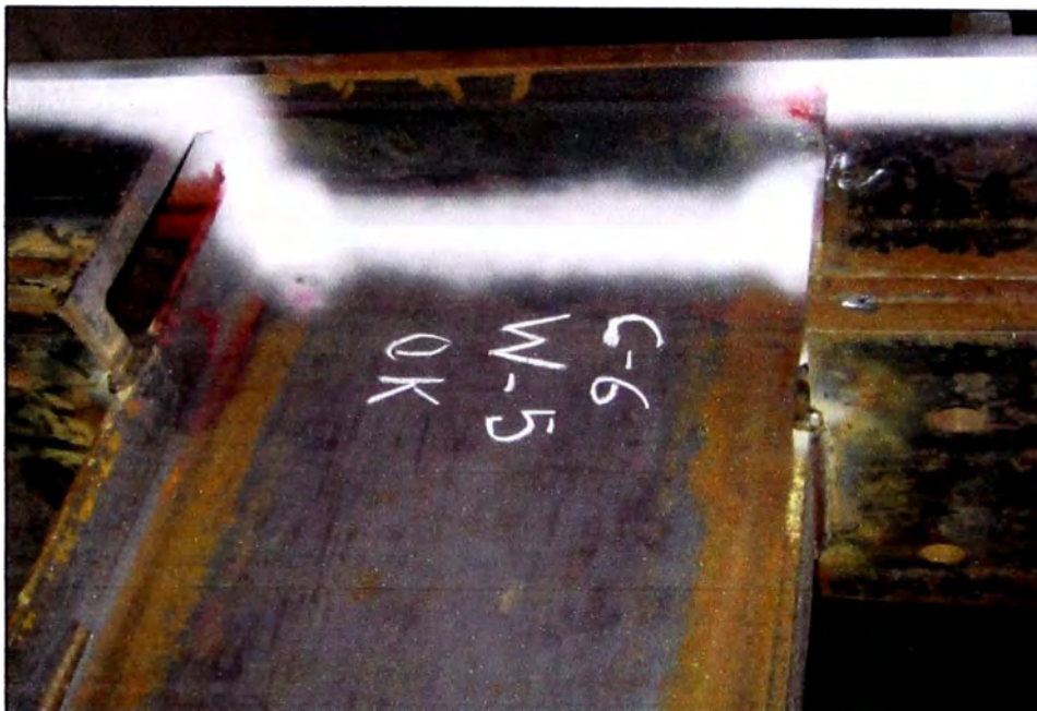
Fig. 3.18 In pección de pase acabado en columnas C-6, soldador w5.
