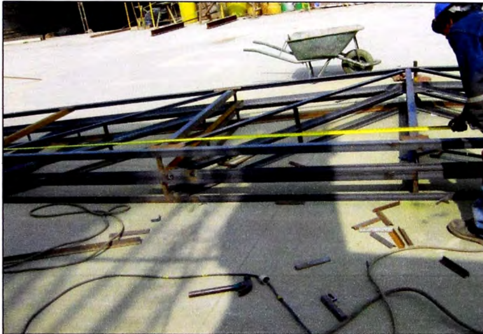
Fig. 3.6 Armado de tijerales según trazo sobre la losa
