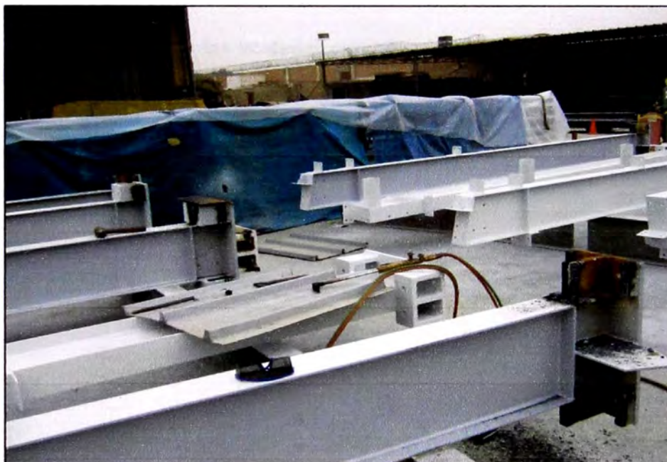
Fig. 3.3 Modificación de todas las silletas de las columnas
