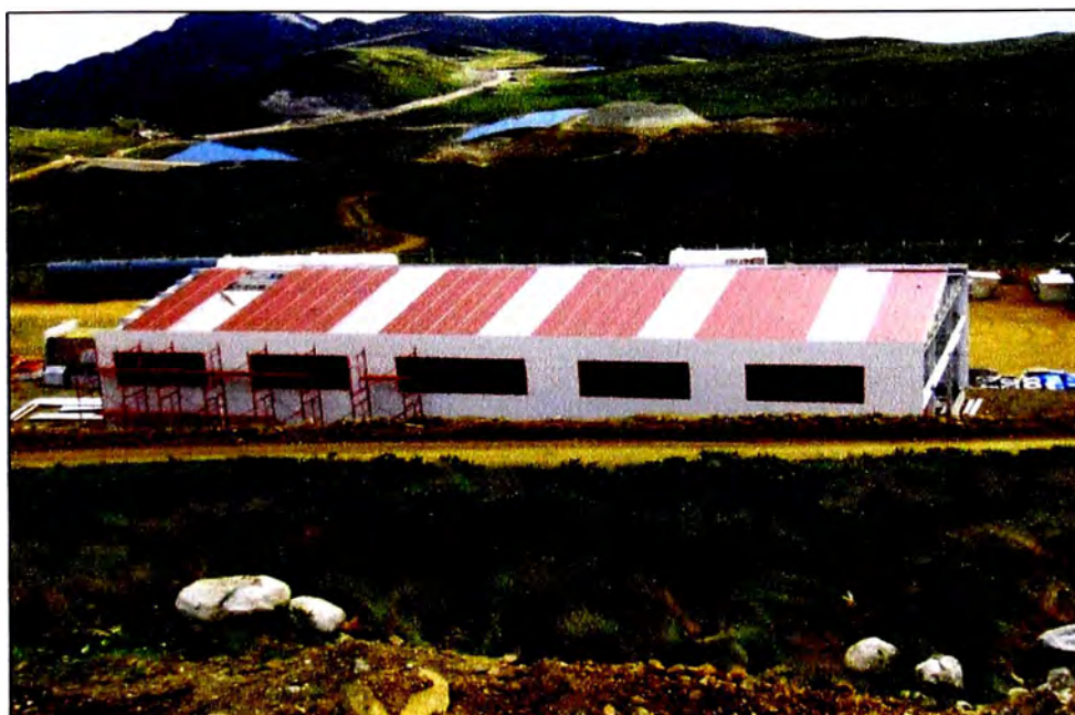
Fig. 3.45 Instalación de planchas traslúcidas en techo
