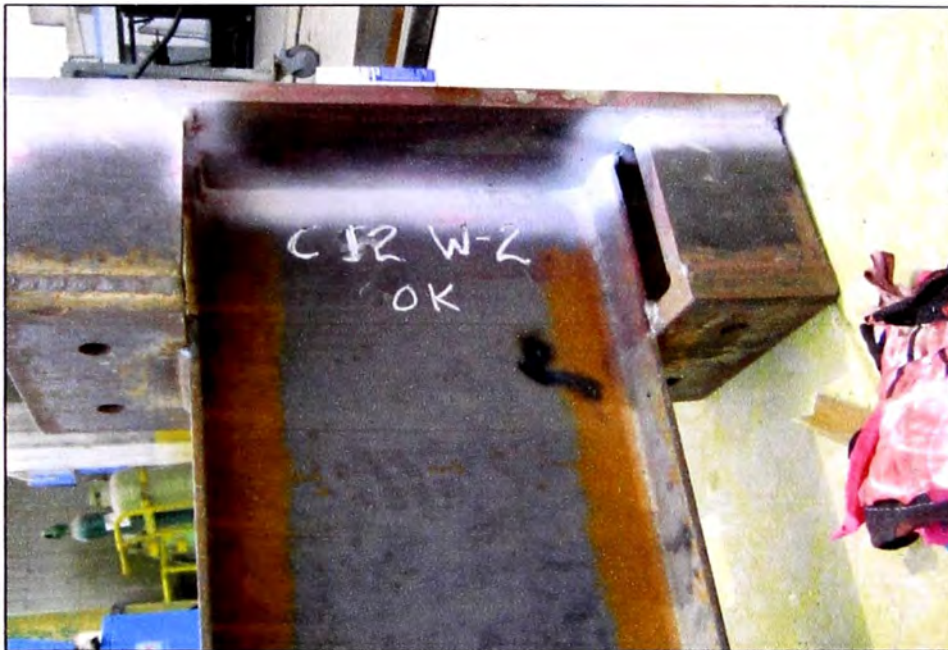
Fig. 3.20 Control de soldadura en columnas C-12, soldador w2. Pase de acabado
