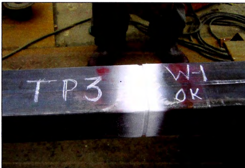
Fig. 3.16 Inspección de pase raíz en amarre pórticos TP-3, soldador w1.
