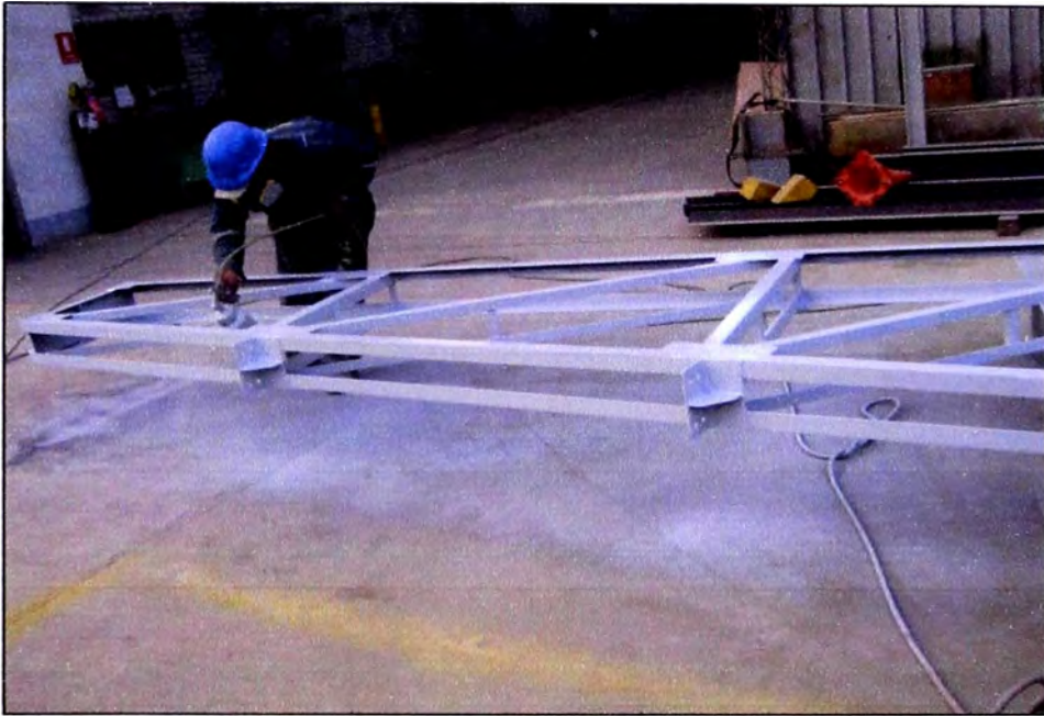
Fig. 3.26 Control de pintura. Aplicación de base a tijeral
