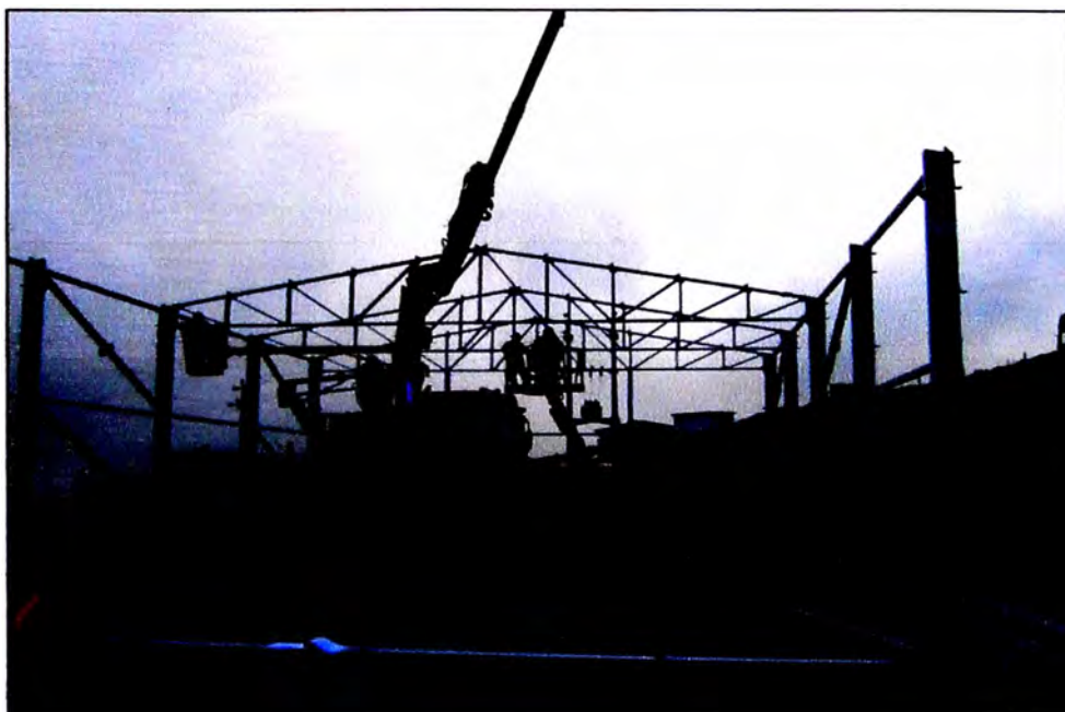
Fig. 3.34 Montaje del tijeral N° 3
