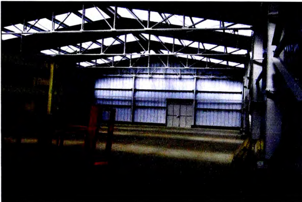
Fig. 4.3 Entrega del Almacén General - Parte interior
