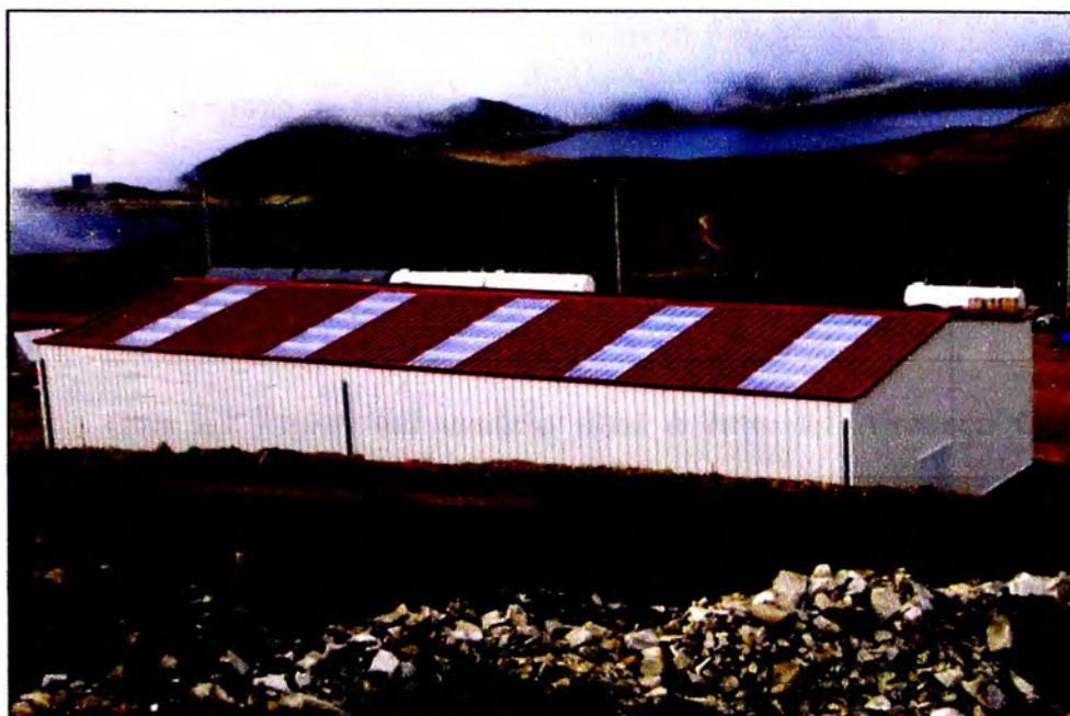
Fig. 4.5 Entrega del Almacén General – Exterior techo
