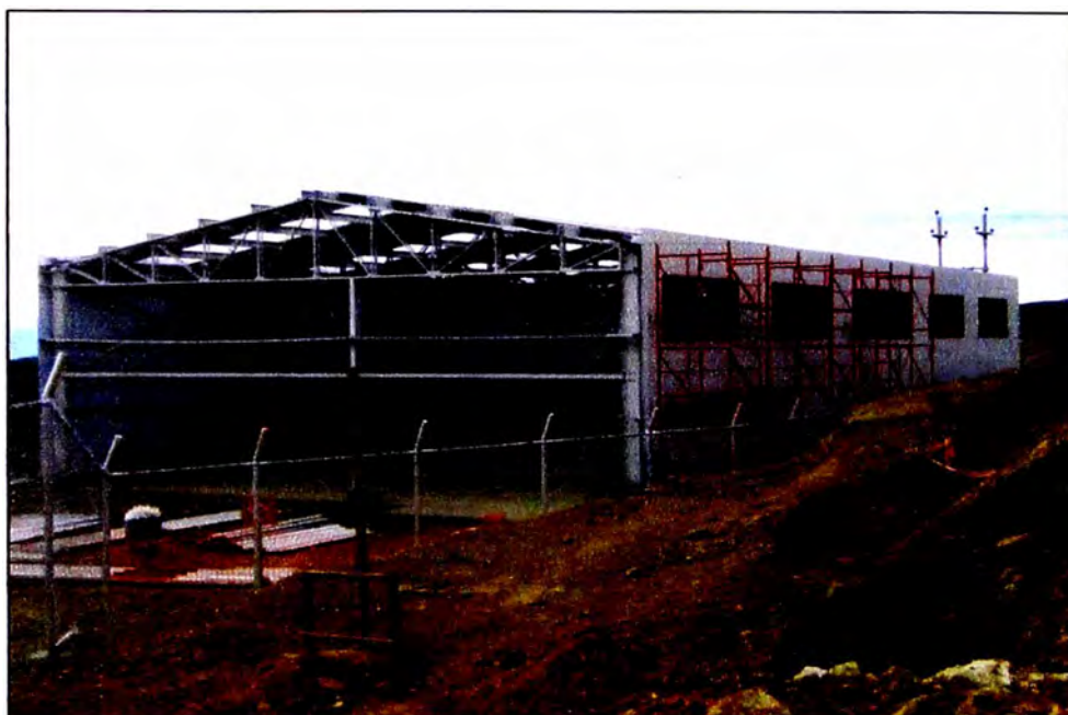
Fig. 3.44 Instalación de cerramientos laterales
