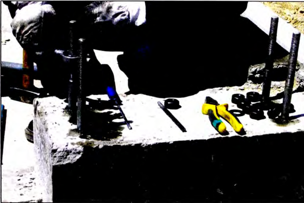
Fig. 3.30 Pasar terraja \text{Ø}3/4'' a todas los pernos de anclaje
