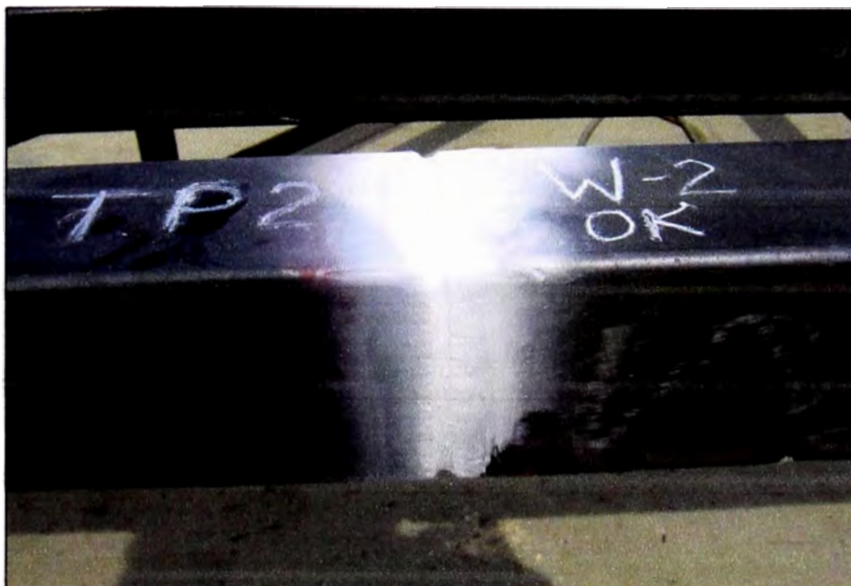
Fig. 3.15 In pección de pase raíz en amarre pórtico TP-2, soldador w2.
