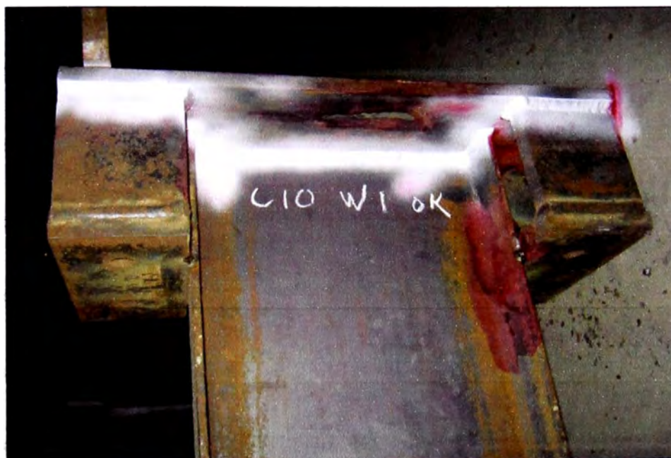
Fig. 3.19 In pección de pase acabado en columnas C-10, soldador w1.
