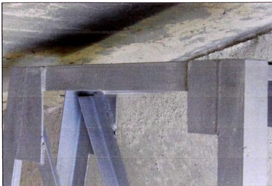
Fig. 3.25 Control de arenado. Tijeral arenado al metal blanco
