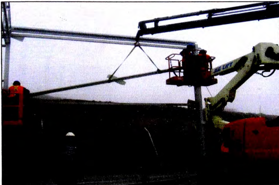
Fig. 3.33 Empernado de arriostres laterales
