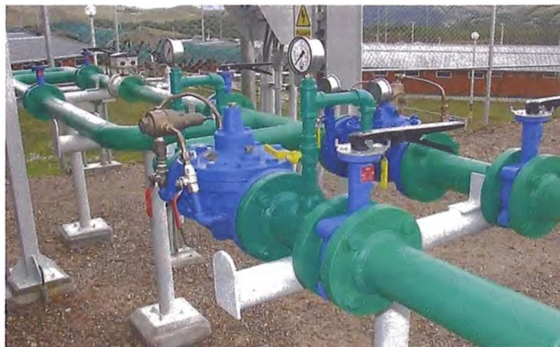
**Figura 3.7 Spool de tubería de acero montada en el km 37**
