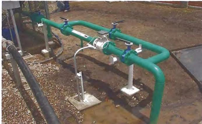
**Figura 3.6 Spool de tubería de acero montada en el km 31**
