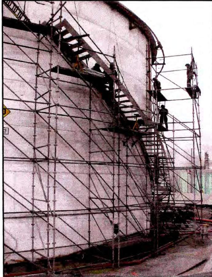
Figura 3.10: Nueva escalera en proceso de instalación
