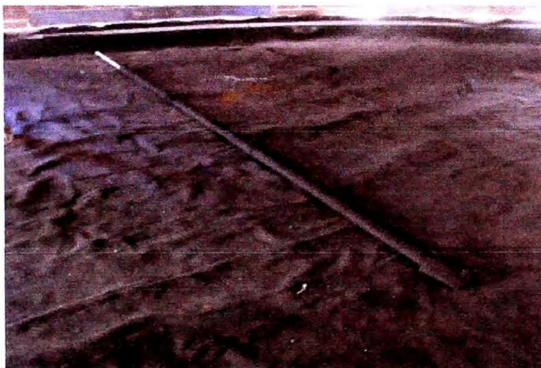
Figura 3.4: Forma de instalación de los testigos de fuga en la base del tanque
