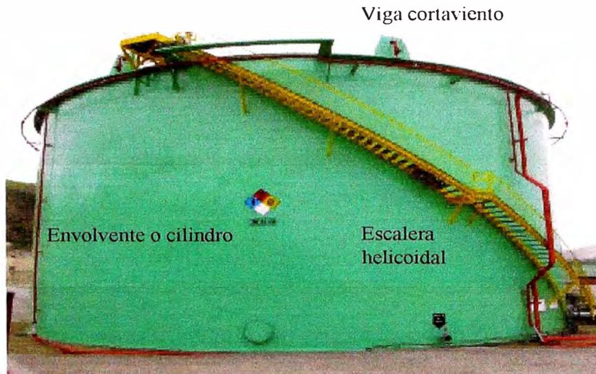
Los techos flotantes van provistos de una escalera rodante con barandilla para acceso a techo
