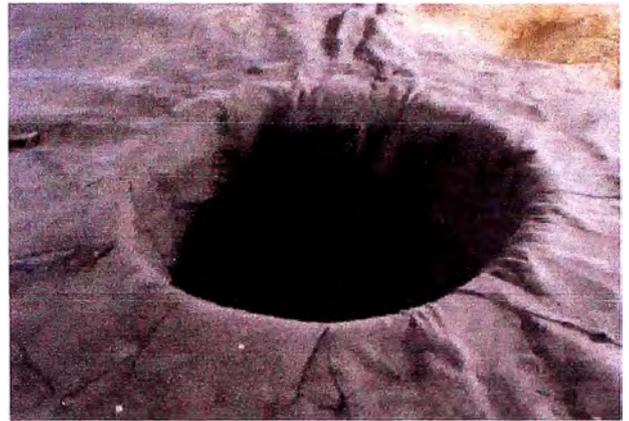
Figura 3.6 Vista de cavidad impermeabilizada donde irá el sumidero.
