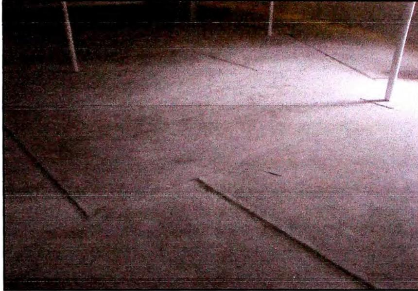
Figura 3.2: Vista de planchas nuevas de fondo ya instaladas.
