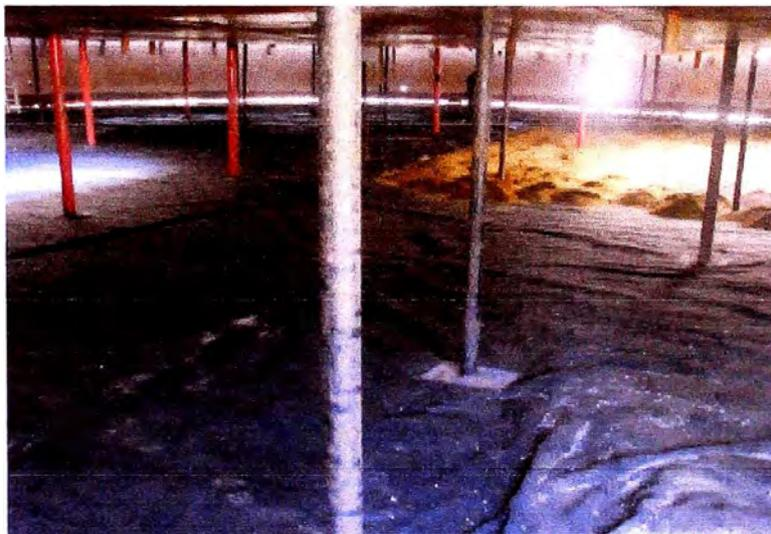
Figura 3.3: Instalación de geomembrana de HDPE en la base del tanque
