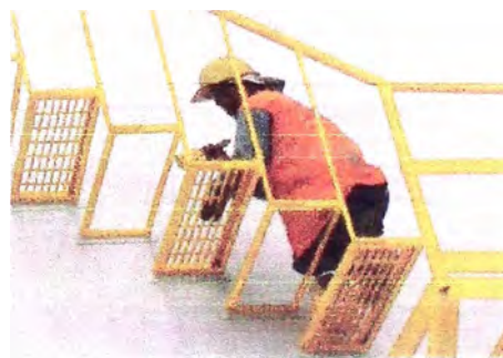
Fig. 4.14 Montaje de escalera con peldaños tipo parrilla.
