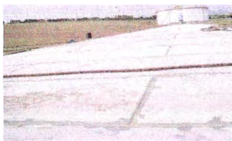
Fig. 4.19 Luego del arenado de uniones soldadas del techo.
