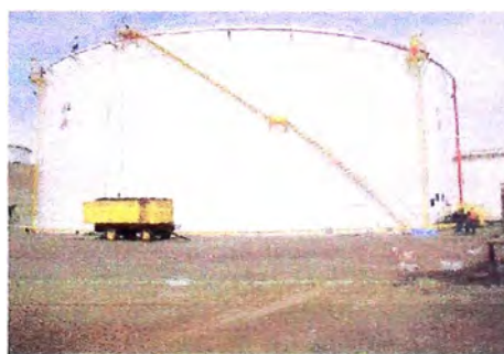
Fig. 4.20 Luego del pintado de la capa de poliuretano.
