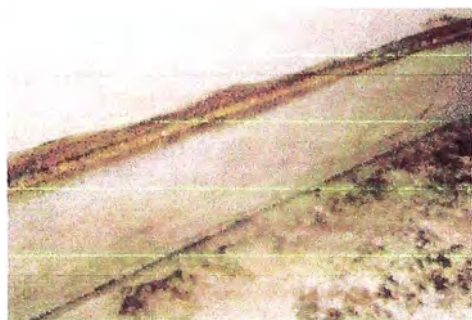
Fig. 4.3 Parche en unión cilindro fondo.
