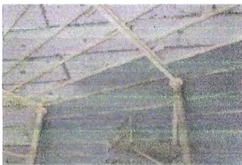
Fig. 4.15 Arenado en el interior del techo de las uniones afectadas por la soldadura.
