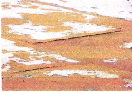
Fig. 4.7 Planchas del techo luego del arenado comercial.
