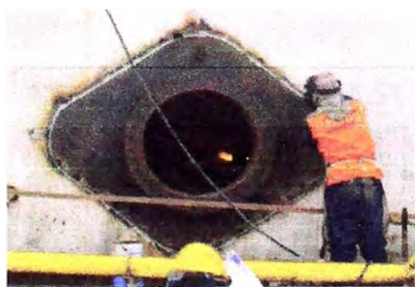
Fig. 4.13 Montaje de manhole de 30"Ø.
