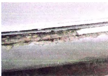
Fig. 4.23 Picado de zonas deterioradas del anillo de concreto.
