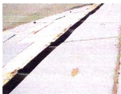
Fig. 4.12 Montaje de planchas pintadas en taller.
