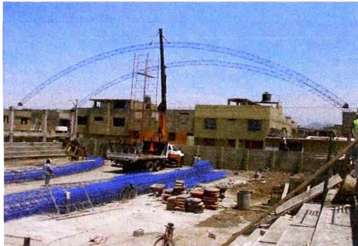
Izado y Traslado de piezas
