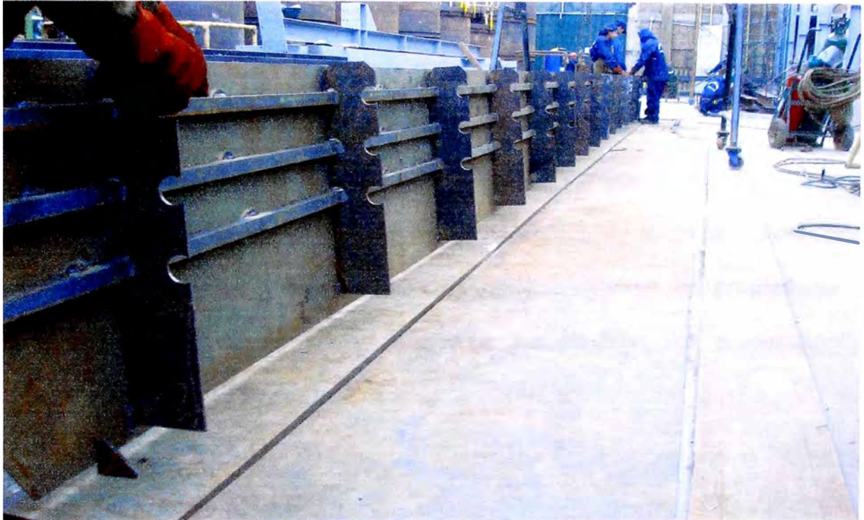
Figura 2.1 Vista del armado de una viga tipo cajón
