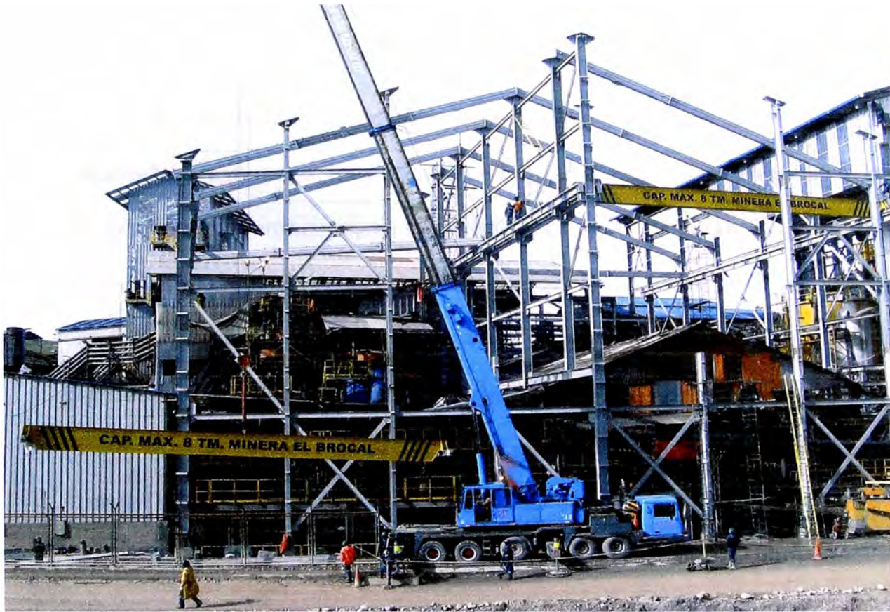
Figura 3.4 Vista del montaje de un puente grúa
