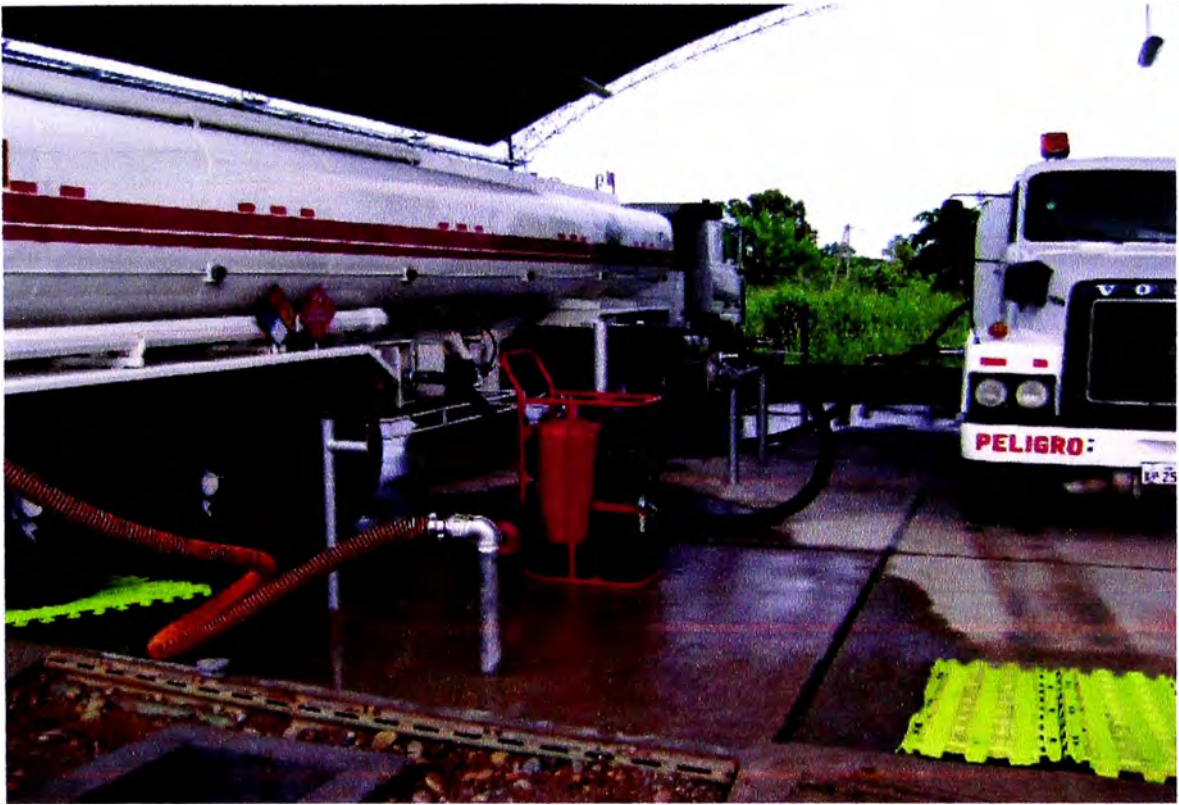
UNIDADES EN OPERACIÓN DE TRASIEGO
