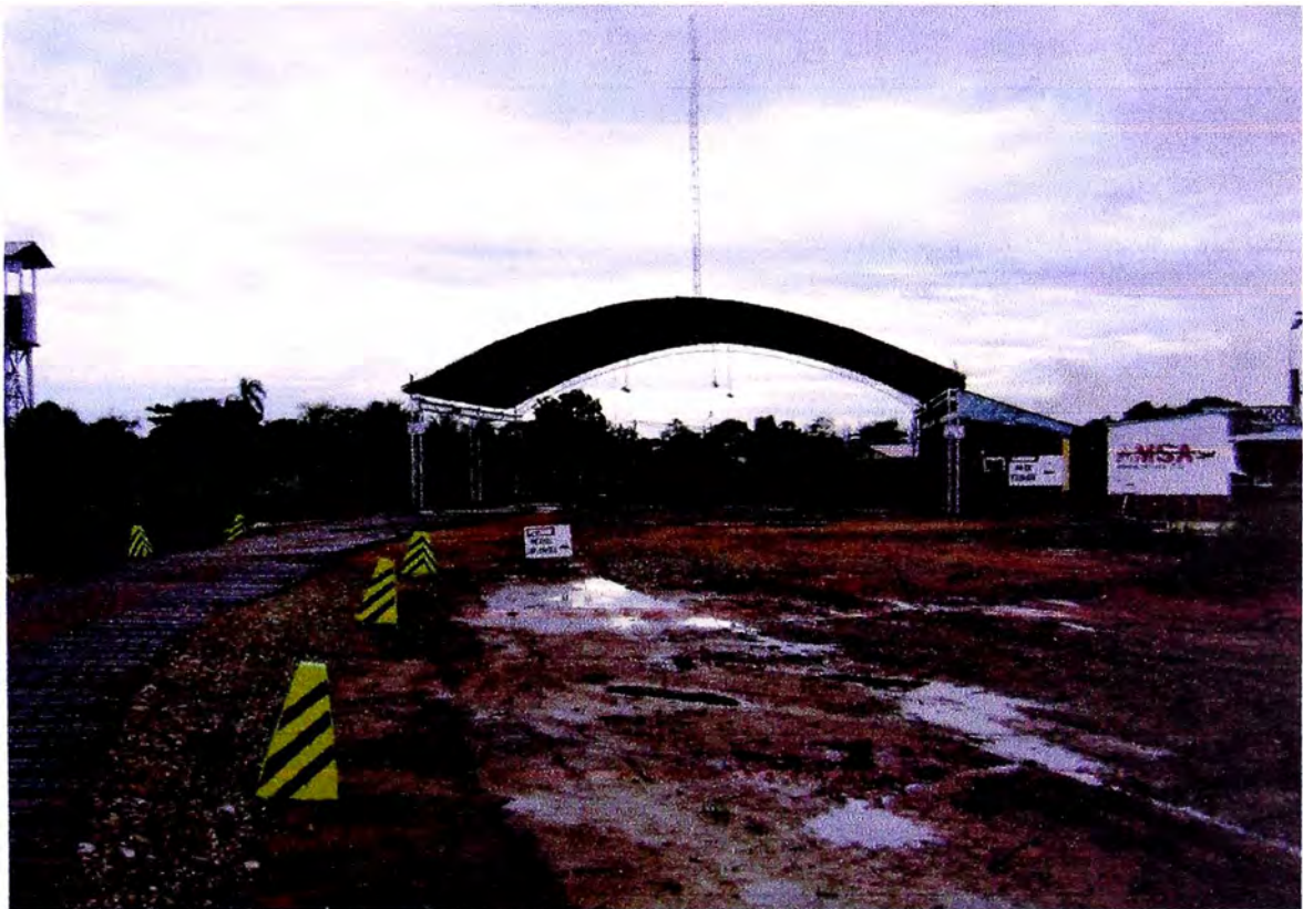
INSTALACION COMPLETA AL 100%
