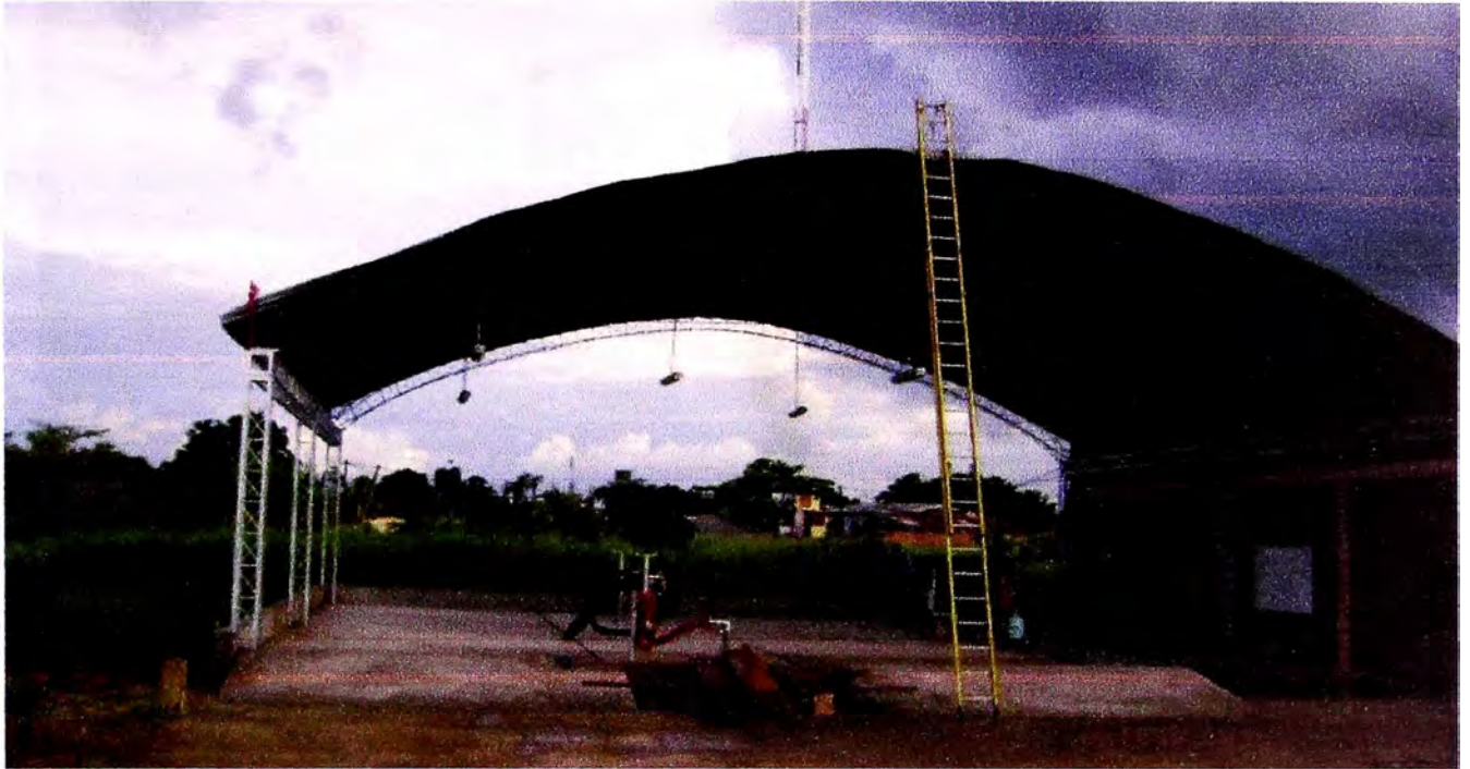
AVANCES AL 90%: INSTAL. MECANICA, ELECTRICA Y PARARRAYOS
