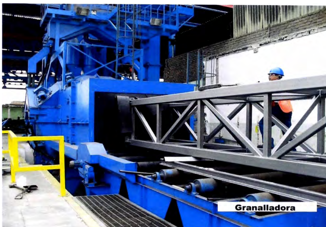
Figura 3.11 Granallado de estructuras (Salida)
