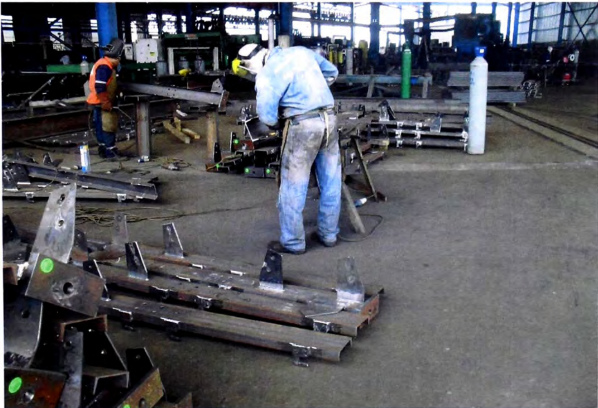
Figura 3.8 Armado de Estructuras
