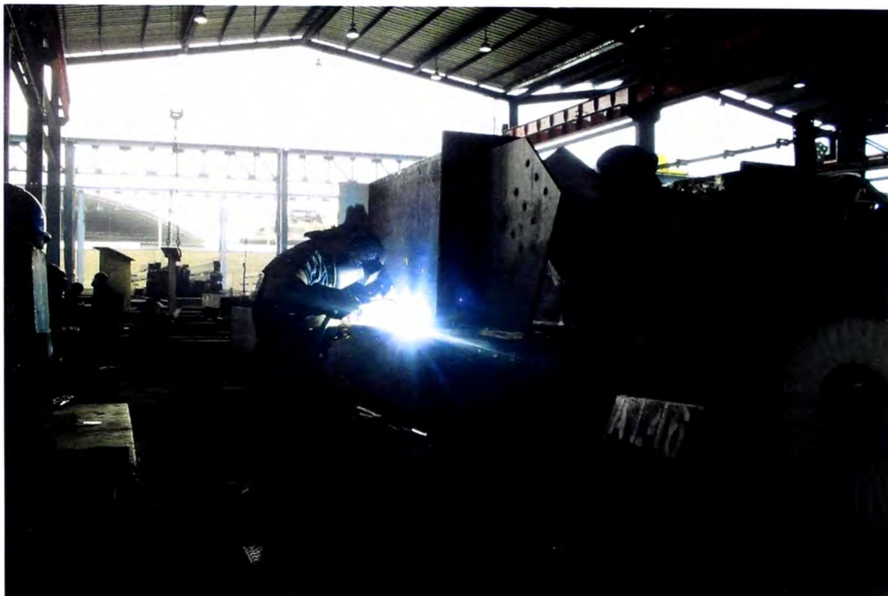
Figura 3.9 Procedimiento de Soldadura
