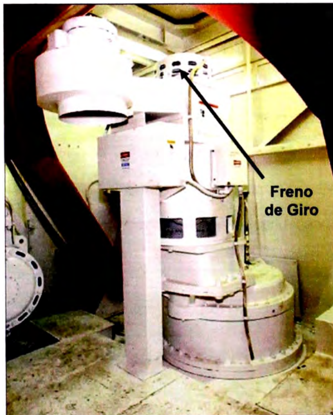
Figura 2-10. Ejemplo de freno de motor de giro
