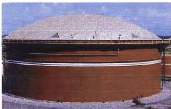
Figura 2.11 – Tanque de techo flotante
