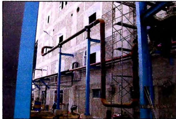
Figura 4.4 Montaje de las tuberias en la soportería.
