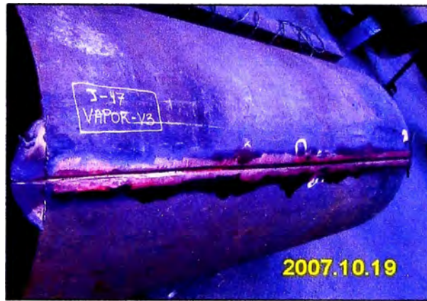
Figura 2.13 Ensayos de fisuras.
