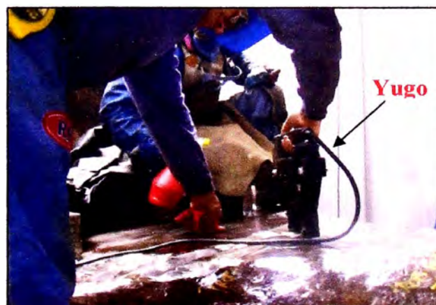
Figura 2.15 Aplicación de MT en una estructura buscado defectos.
