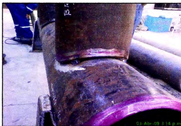
Figura 4.3 Armado del Manifold de Válvulas.
