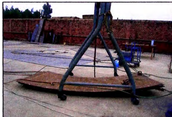
Figura 4.6 trazado y habilitado de planchas estructurales ASTM A36.
