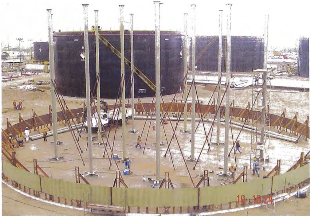
Foto N° 3.16: Montaje de las columnas de soporte del techo
