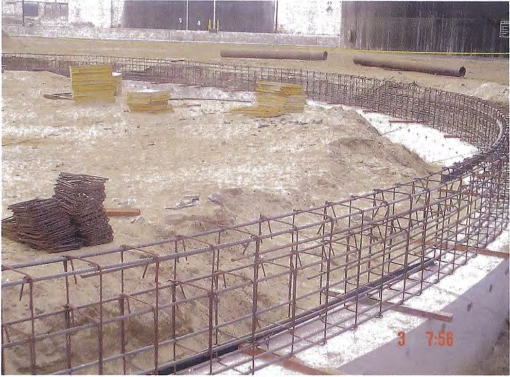
Foto N° 3.5 Instalación de la armadura de varillas de acero corrugado
