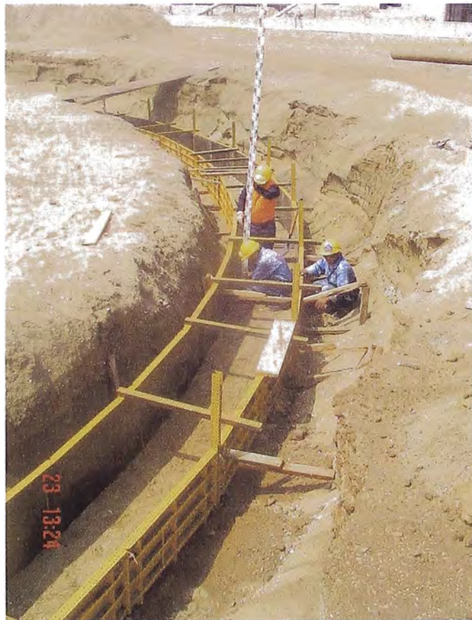
Foto N° 3.3: Encofrado de sub-base de cimentación del tanque
