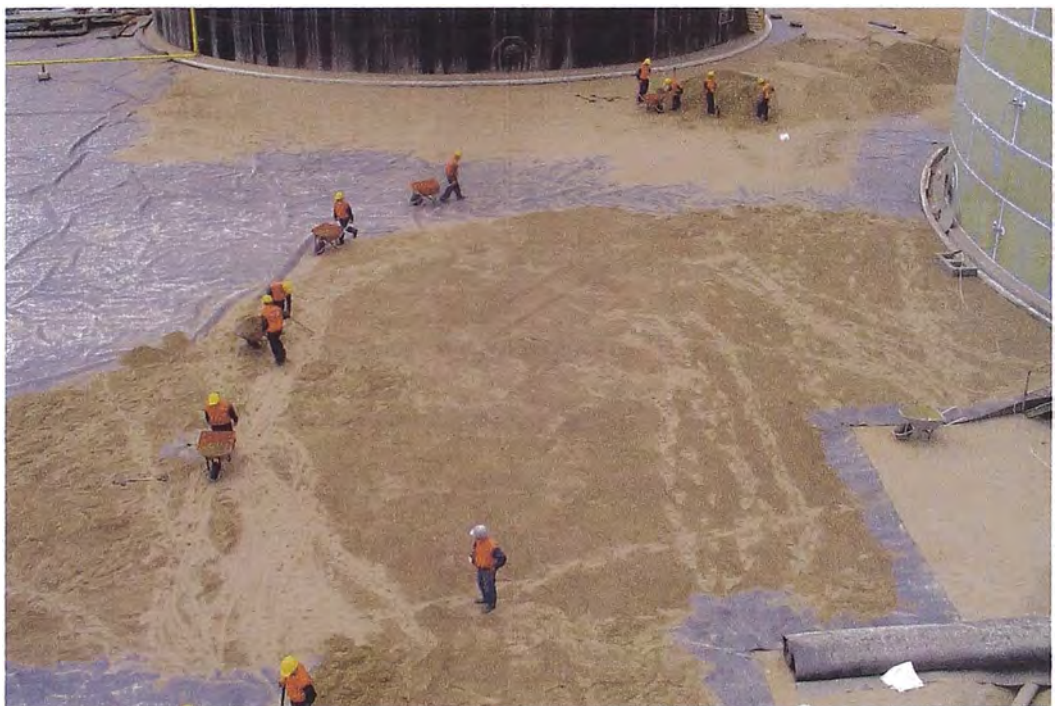
Foto N° 3.10: Aplicación de capa de 5cm de arena limosa
