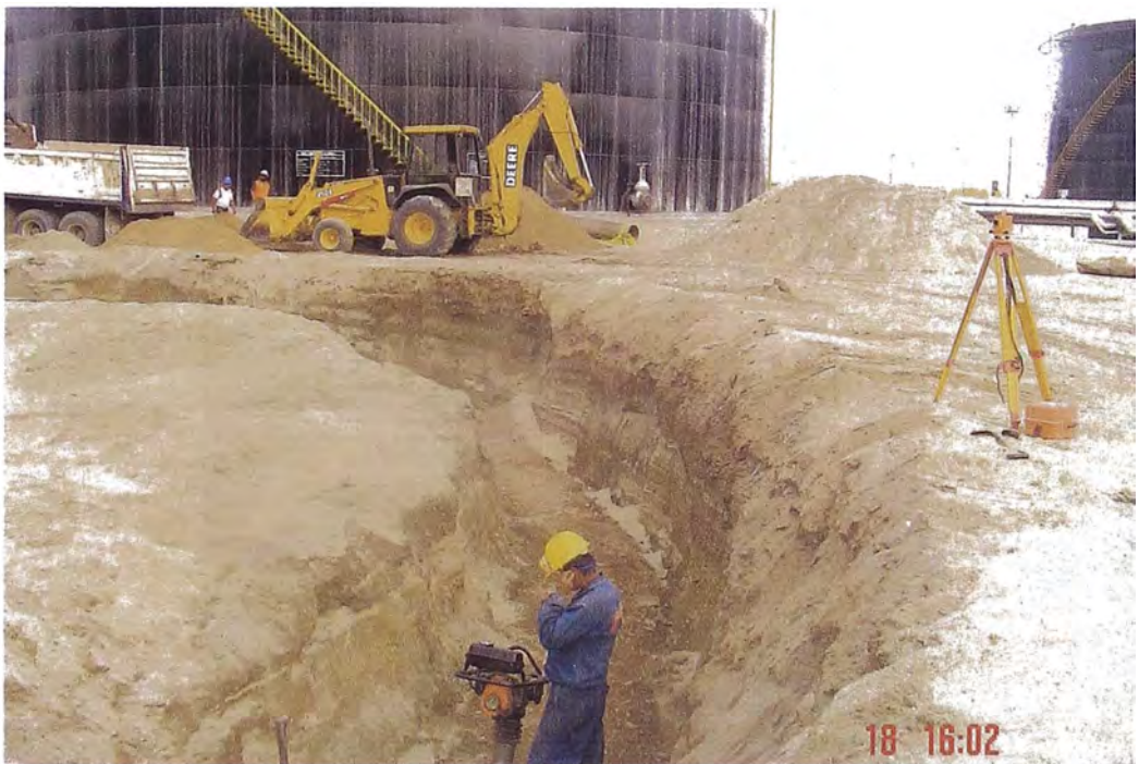
Foto N° 3.2: Afirmado y compactado del terreno
