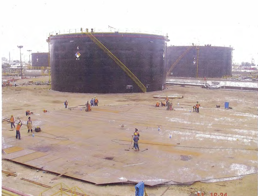
Foto N° 3.12: Instalación de las planchas del fondo
