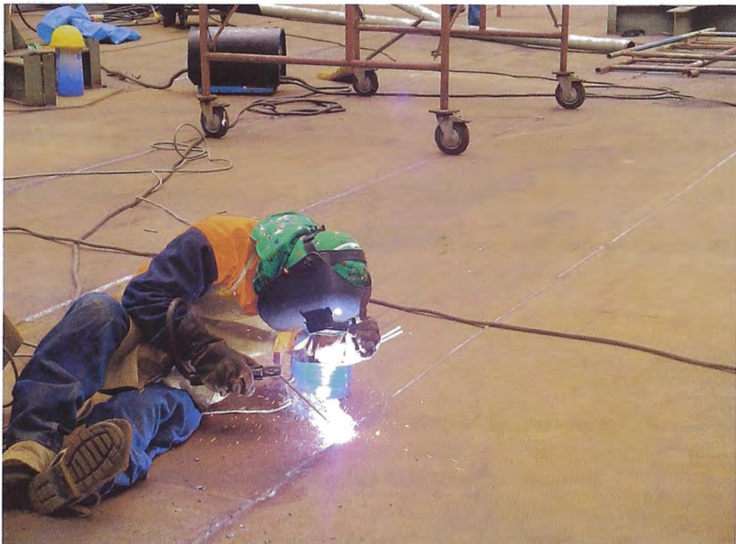
Foto N° 4.1: Reparando un defecto en las planchas del fondo
