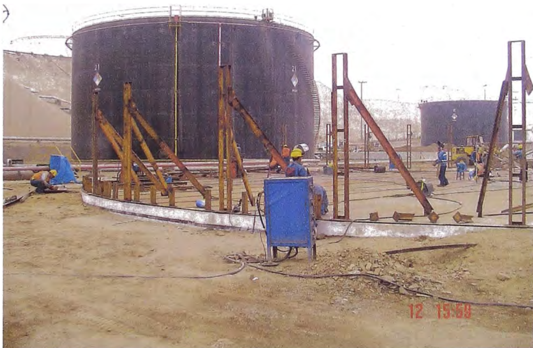
Foto N° 3.13: Sistema de montaje anillo bajo Anillo
