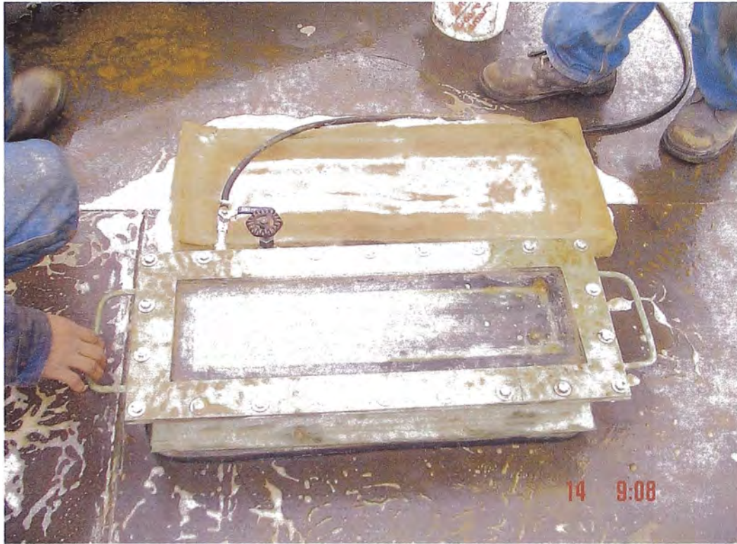
Foto N° 4.2: Prueba de vacío en la soldadura de las planchas del fondo
