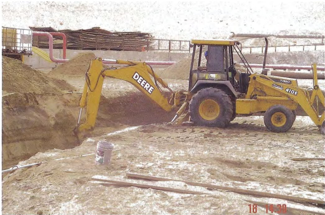
Foto N° 3.1: Detalle de la excavación
