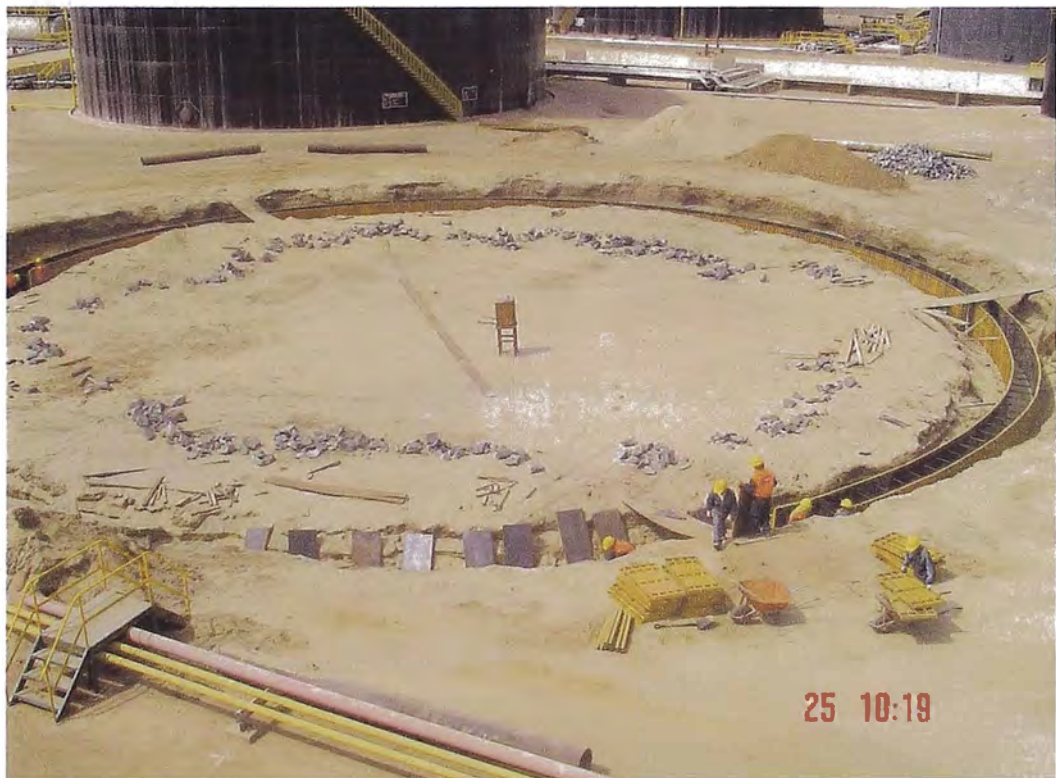
Foto N° 3.6: Vaceado de Concreto en sub-base Tanque N° 54
