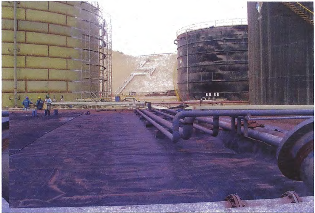
Foto N° 3.9: Instalación del geomembrana en el interior del cubeto.
