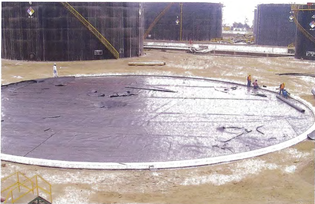
Foto N° 3.7: Instalación de geromembrana en el Tanque N° 54
