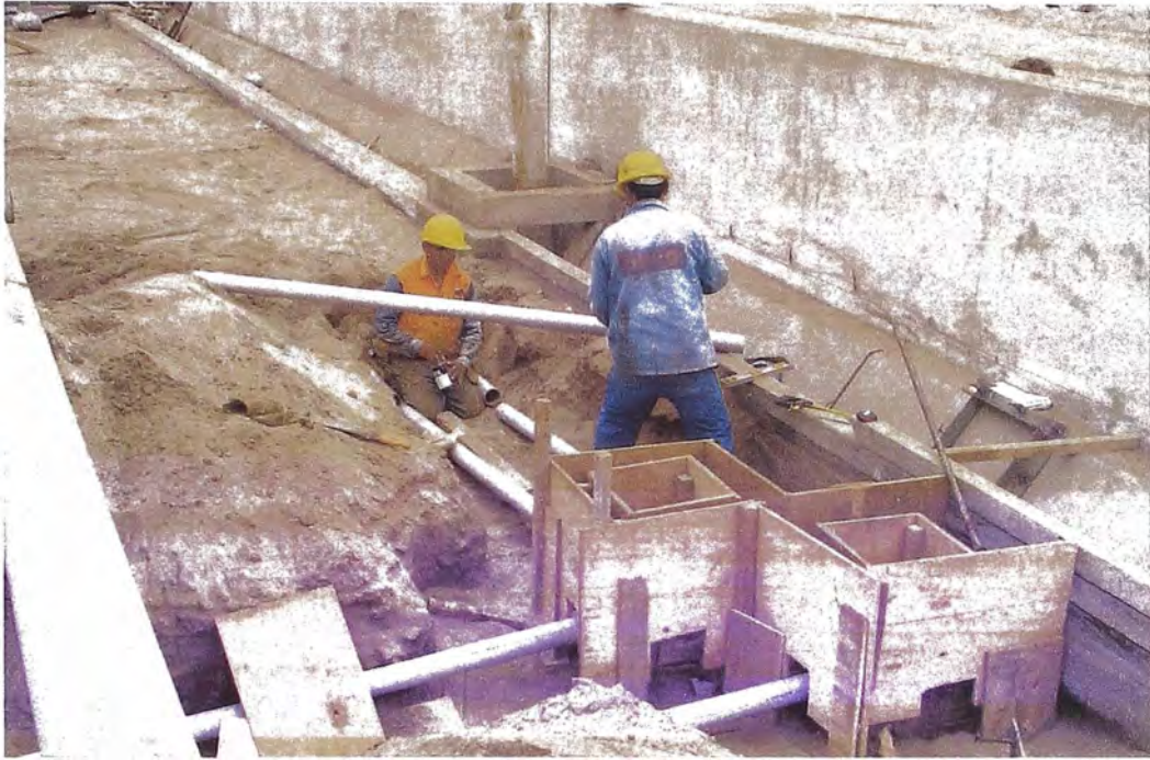
Foto N° 3.22: Construcción del Buzón eléctrico
