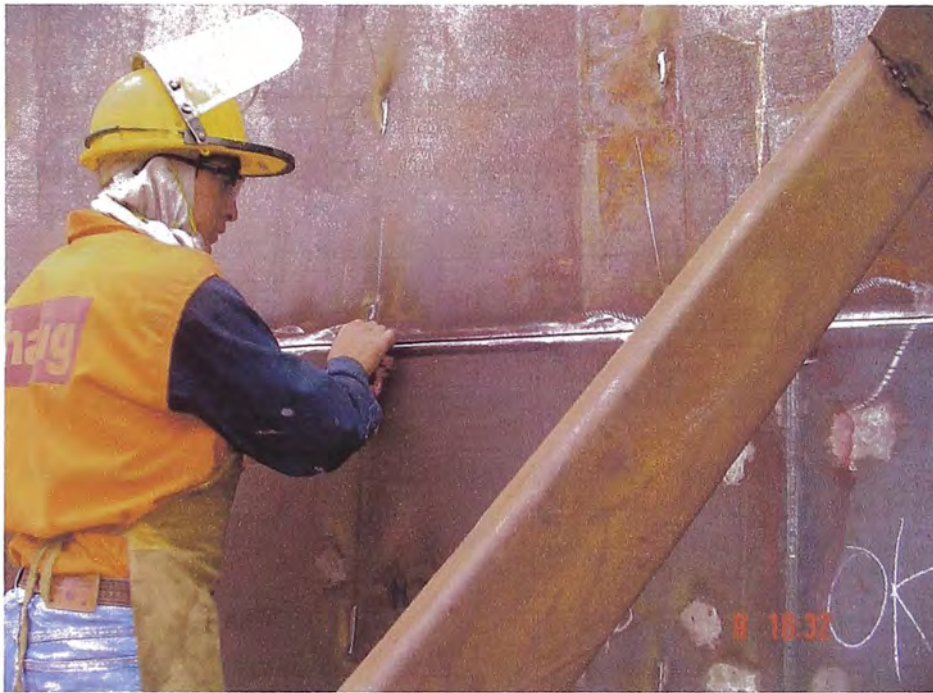
Foto N° 4.3: Prueba de tintes penetrantes en la soldadura del cilindro
