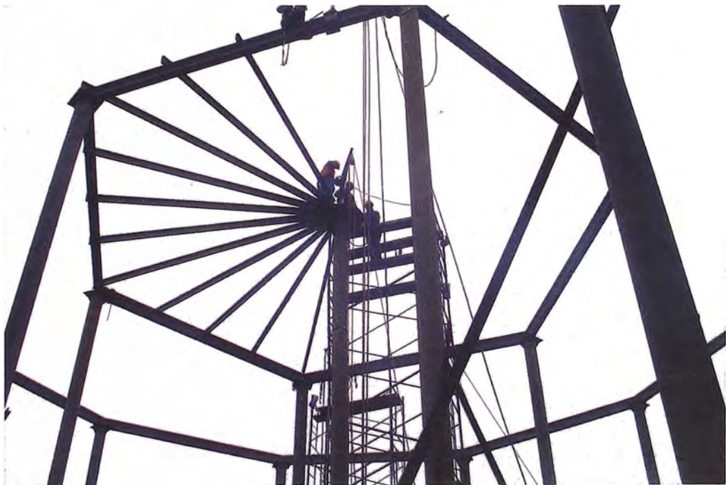
Foto N° 3.17: Montaje vigas y viguetas
