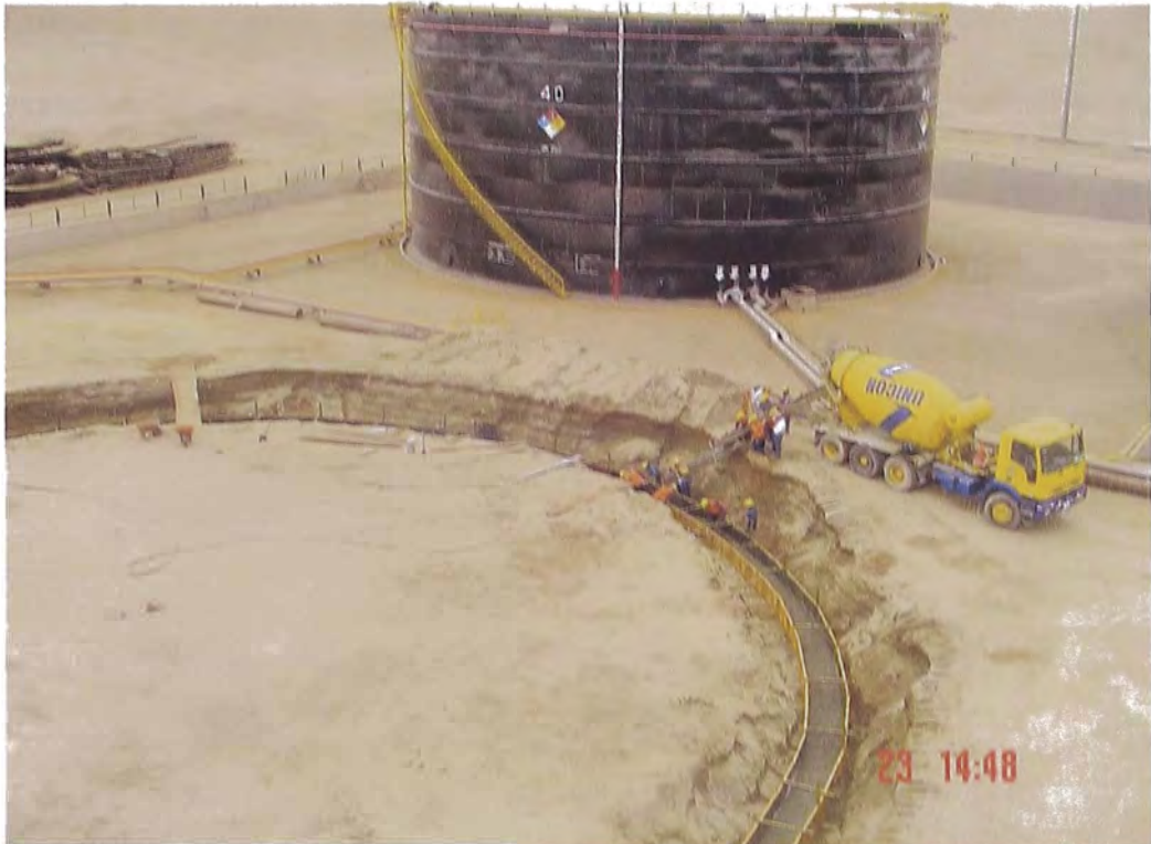
Foto N° 3.4: Vacado de concreto Sub-base Tanque 54
