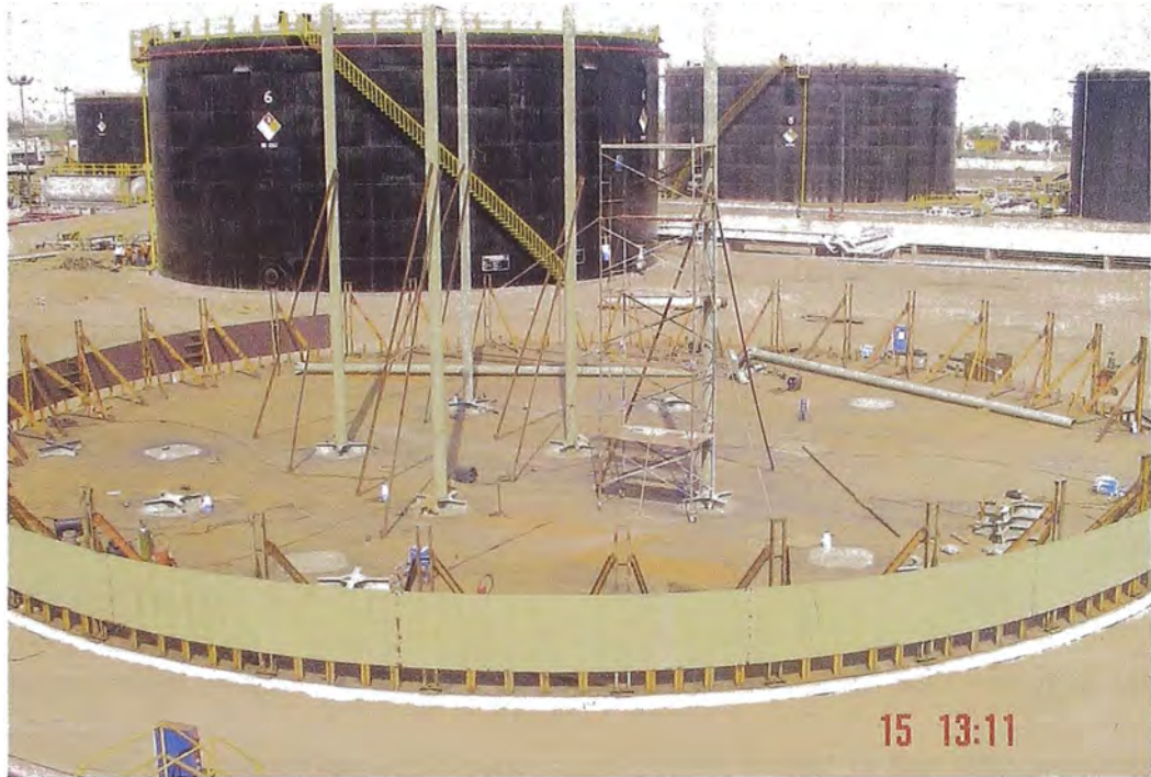
Foto N° 3.14: Montaje del Anillo No. 10.
