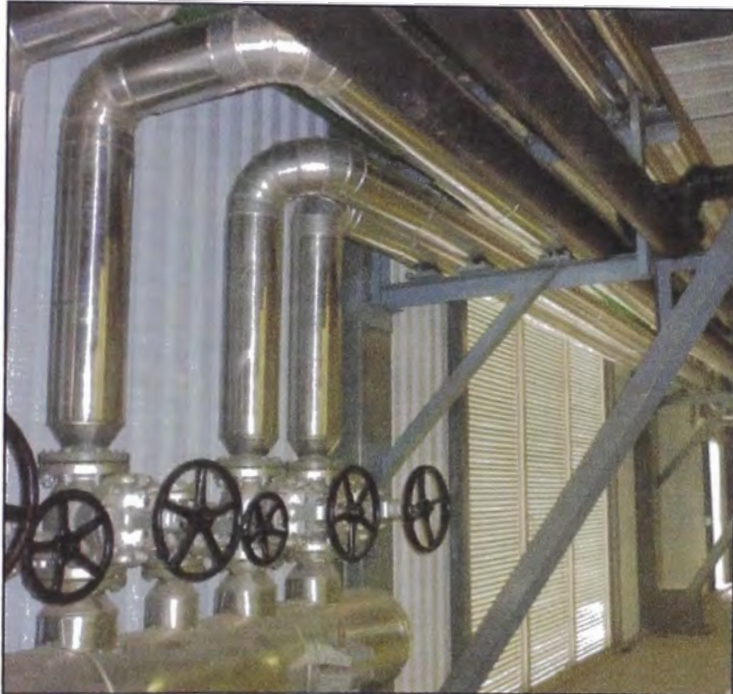
Figura 3.22 Manifold Secundario
