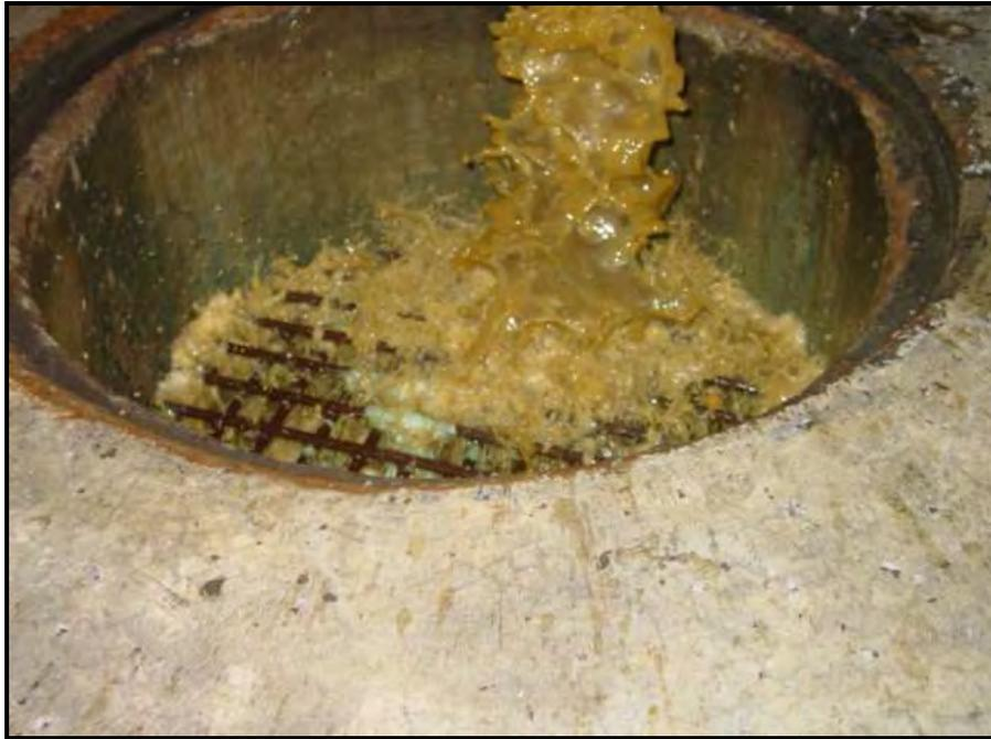
**Foto V. Descarga de agua residual de baño portátil en alcantarillado**
