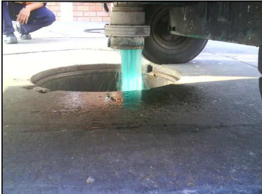
Foto VI. Descarga de agua residual de baño portátil en alcantarilla.
