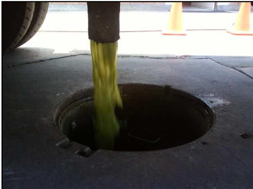
**Foto IV. Descarga de agua residual de baño portátil en alcantarilla.**
