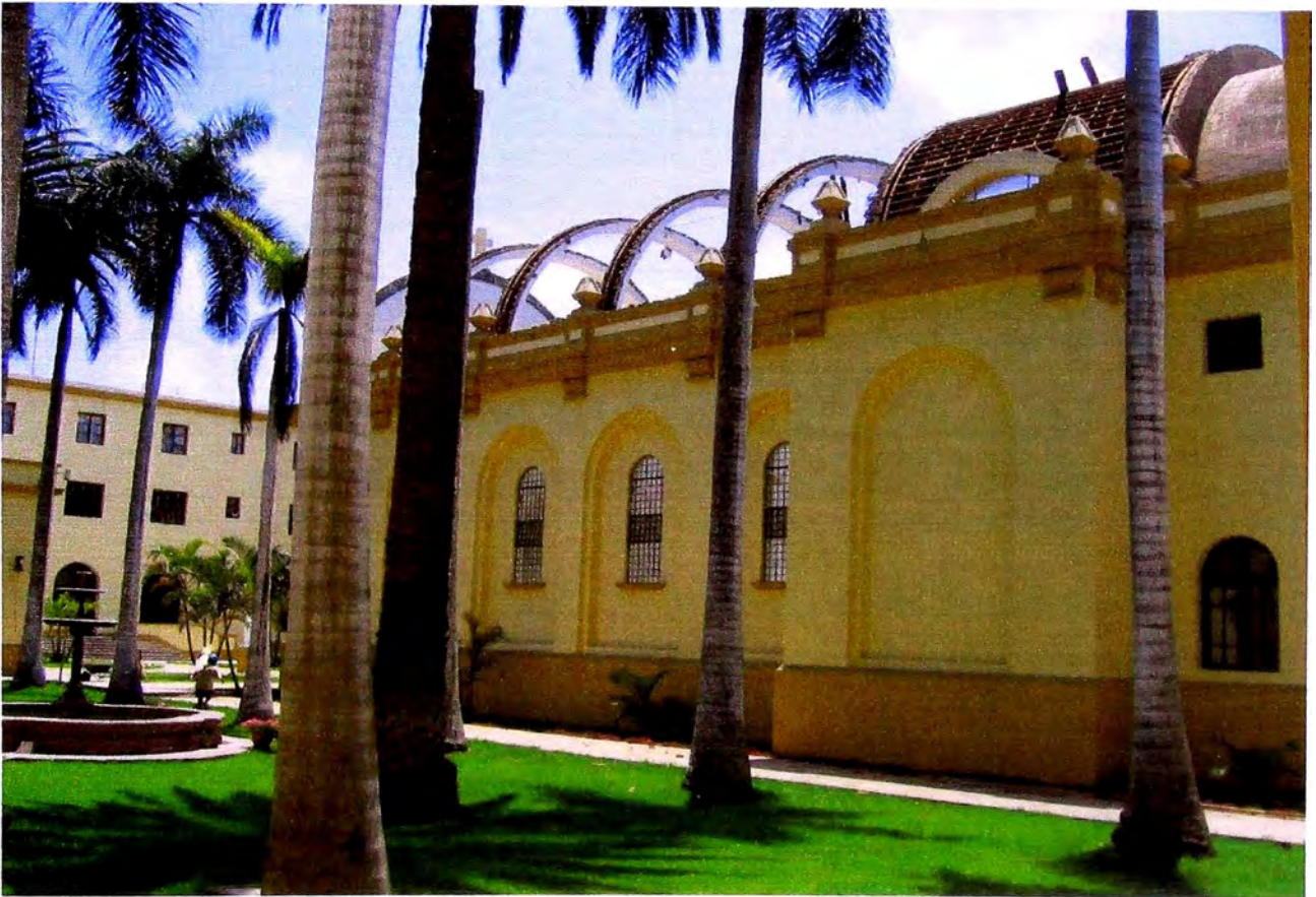
Vista de la capilla en el proceso de sacar la cobertura
