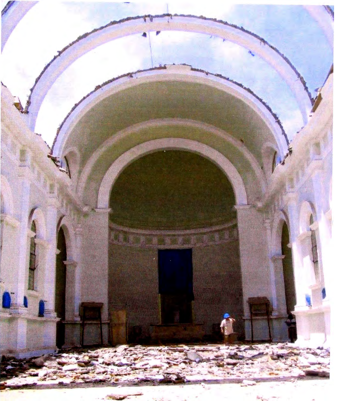
Vista interna de la capilla en el momento de la demolición del techo
