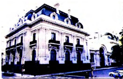
Figura 5.3. Sistema VRV es adaptable a edificios con limitaciones de espacio
