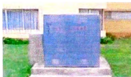
Figura 2.11. Subestación de distribución compacta (pedestal y bóveda)
