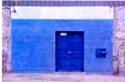
Figura 2.9. Subestación de distribución convencional
