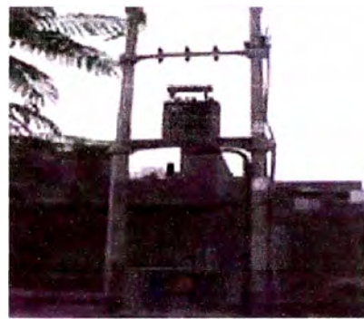
Figura 2.10. Subestación de distribución aérea (monoposte y biposte)
