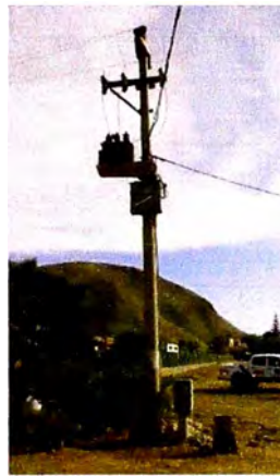
Figura 2.10. Subestación de distribución aérea (monoposte y biposte)
