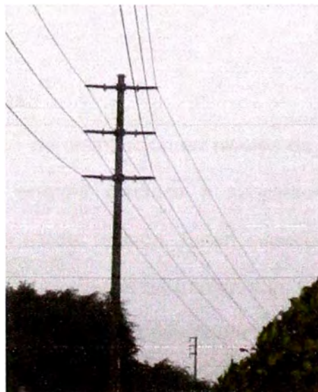
Figura 2.2. Red de alta tensión
