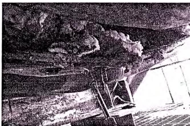
Fotografías de una junta de expansión: Modelo C-700F (deteriorada), con presencia de fuga de gases y formación de sulfatos de cobre.
