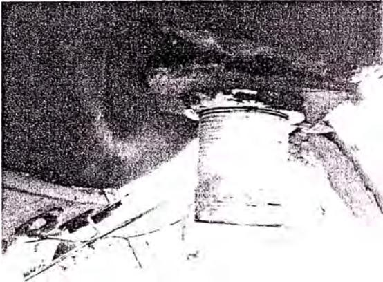
Junta #27. Refuerzo del drenaje desprendido
