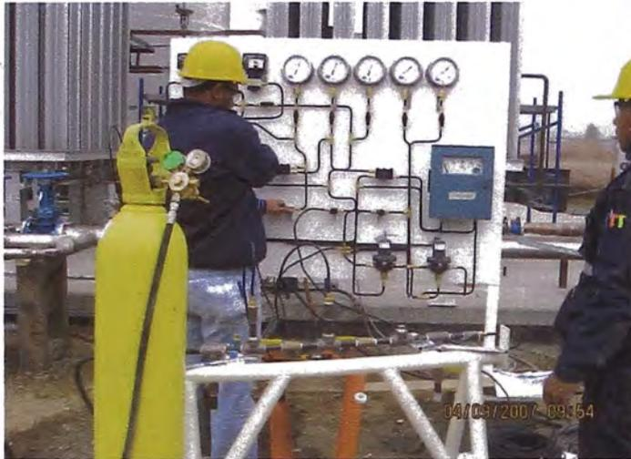
Construcción de Panel de Instrumentos de Control en la Línea de Oxígeno Líquido / Gaseoso
