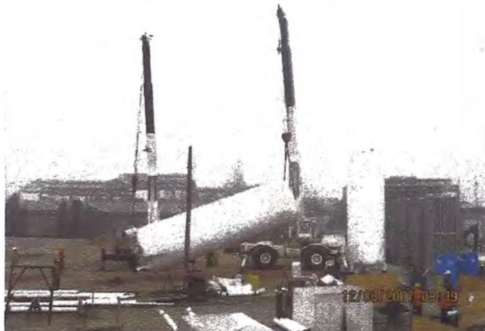
Maniobras de Carga para la Instalación de Tanque Criogénico
