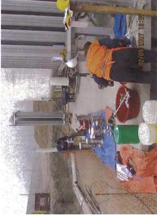
Limpieza interna con EnSolv de Tubos de Cobre
