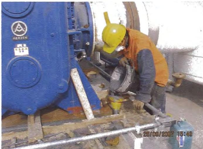
Instalación de Grouting en la Base del Soplador de Alimentación
