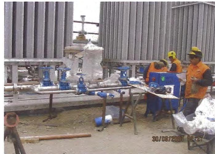
Instalación de Spools, Válvulas, Instrumentos
