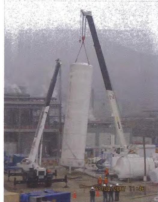
Maniobras de Carga para la Instalación de Tanque de Almacenamiento de Oxígeno Gaseoso - Continuación
