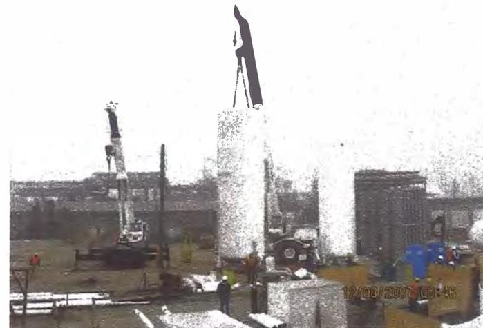
Maniobras de Carga para la Instalación de Tanque Criogénico - Continuación
