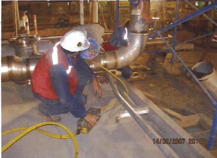
Preparación de Juntas Soldadas para Aplicar Placa Radiográfica
