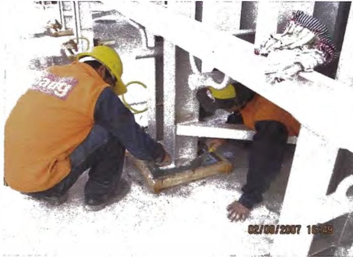
Instalación de Grouting en la Base de los Vaporizadores
