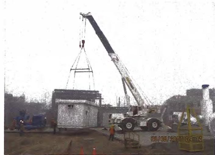
Maniobras de Carga para la Instalación de la Sala Eléctrica
