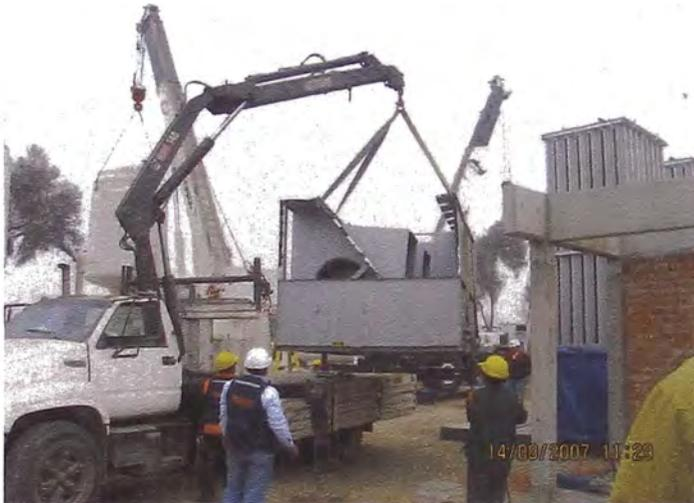
Maniobras de Carga para la Instalación de Torre de Enfriamiento
