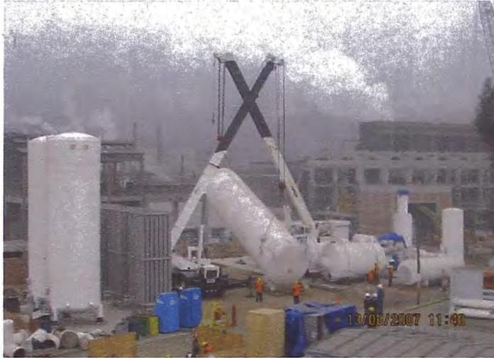
Maniobras de Carga para la Instalación de Tanque de Almacenamiento de Oxígeno Gaseoso
