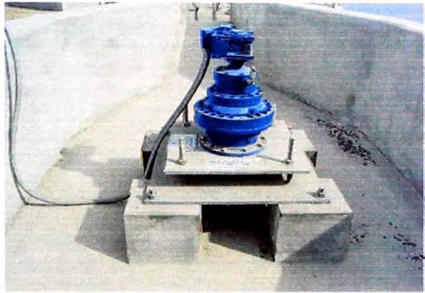
Foto Nº 56 Motoreductor de espesador
