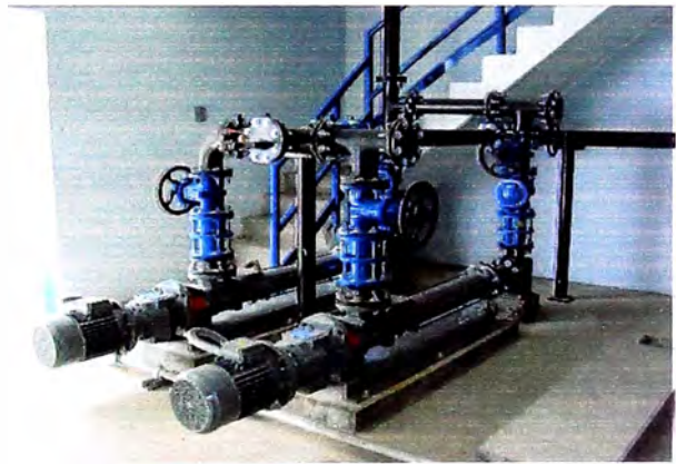
Foto Nº 57 Bomba Tipo Tornillo para los lodos
