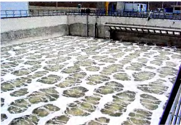
Foto N° 37 Llenado del Tanque ICEAS detergentes
