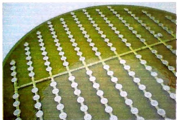
Foto Nº 59 Tanque de aireación de lodos
