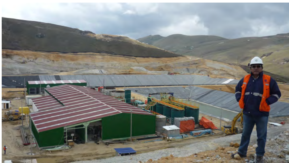
Foto 2: Vista general de la planta de operaciones Merrill & Crowe
