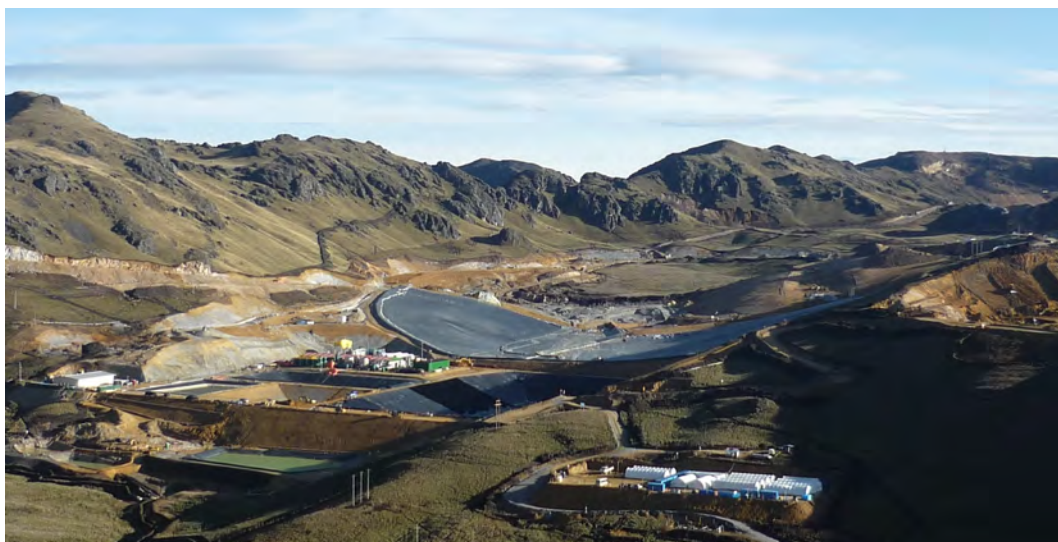
Foto 1: Vista general de la ubicación del proyecto.
