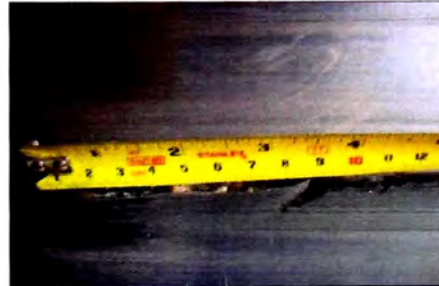
La foto muestra un corte del cover de 15 cm aproximadamente (criticidad 4)
