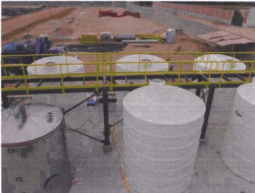
Figura 3.5: Tanques de almacenamiento de UAN 32 de 25000 galones en polipropileno
