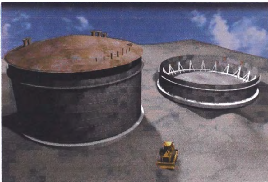
Figura 2.8: Montaje del techo del tanque
