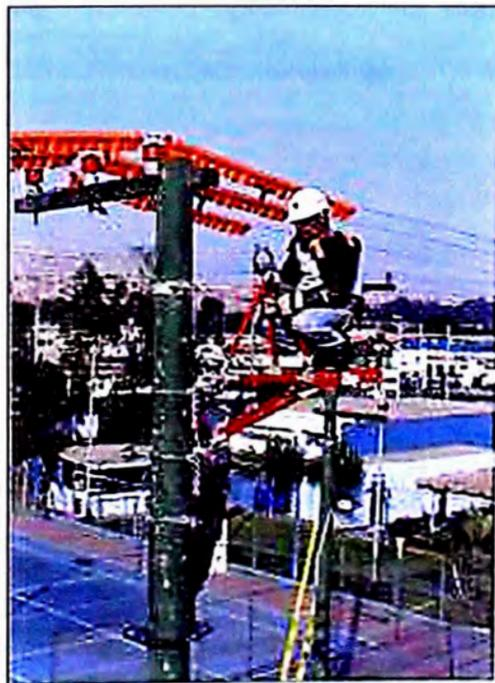
Ilustración 3.4. Trabajos a contacto a través de una plataforma aislada
