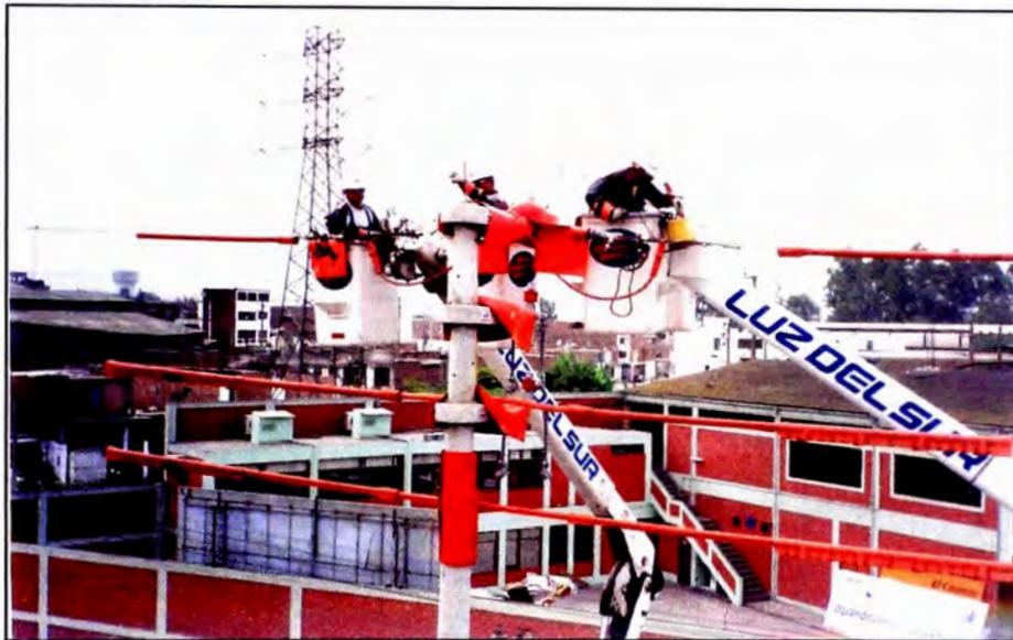
Ilustración 3.3. Trabajos a contacto, a través de un brazo hidráulico aislante
