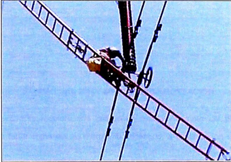
Ilustración 3.5. Trabajo a potencial, con el uso de un traje conductivo y escaleras aislantes
