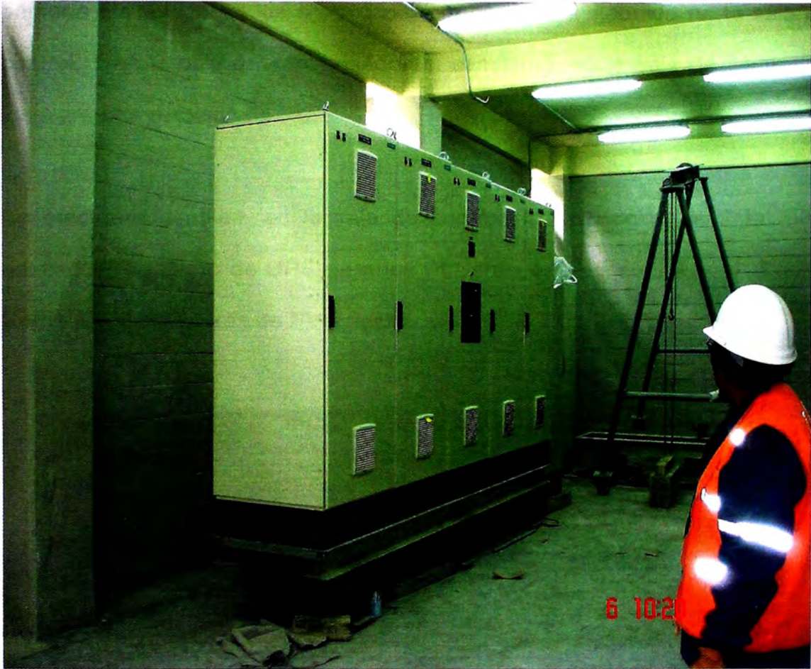
Ilustración 3.3 Modelo de centro de control de motores
