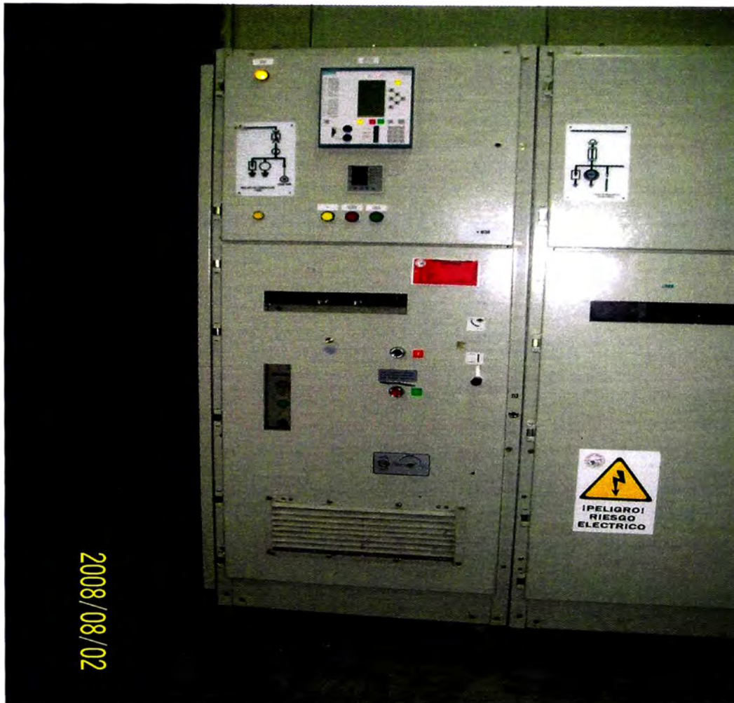
Ilustración 3.1 Modelo de celda de salida
