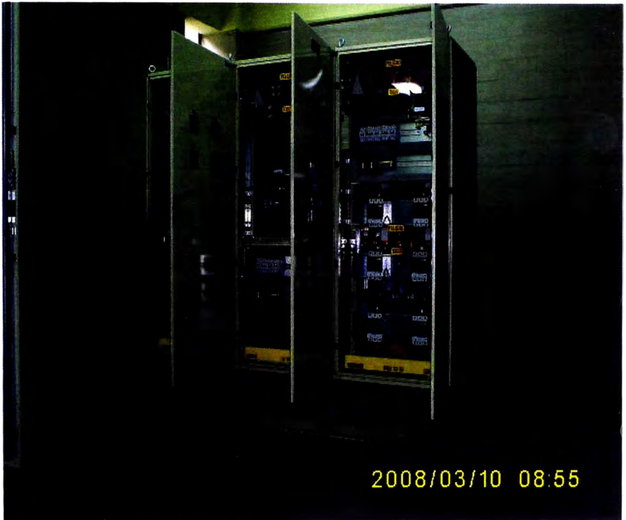
Ilustración 3.2 Modelo de tablero de distribución principal
