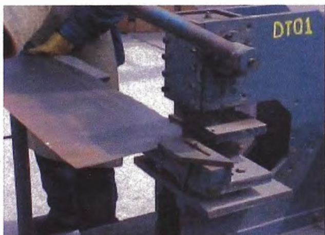
COLOCACIÓN DE PLANCHA
