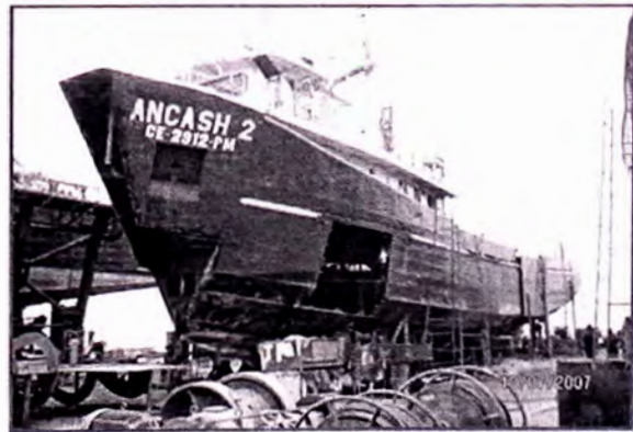
MODULO UBICADO EN SU POSICION FINAL.
