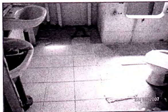
Figura 3.83: Vista de la instalación de cerámicos en el baño de la tripulación.
