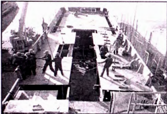
ERECCION DEL MODULO DE ESTRIBOR.
