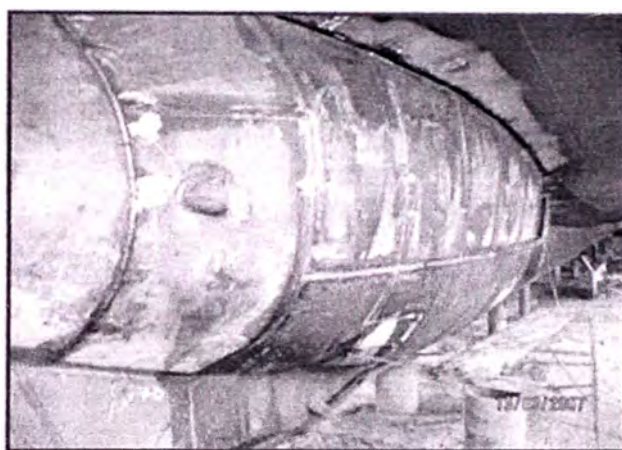
PRUEBA DE ESTANQUEIDAD DEL BULBO DE POPA
