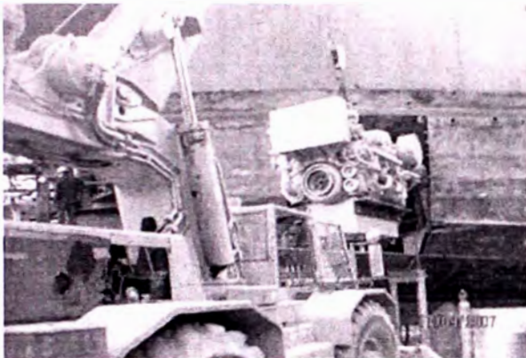
MANIOBRA DE INGRESO DE UN MOTOR AL CASCO
