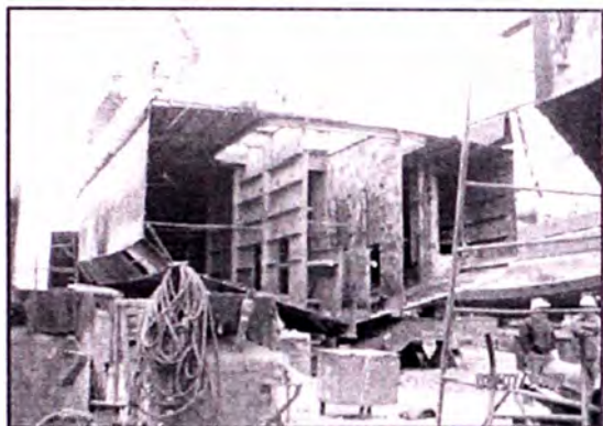
BODEGAS ANTES DE INICIAR EL ARENADO
