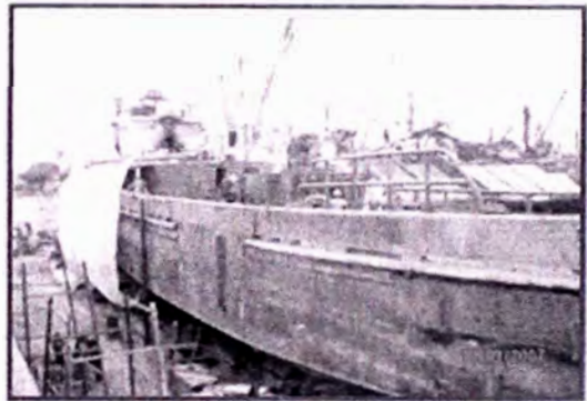
SOLDADURA DEL CASCO SECTOR CENTRO.
