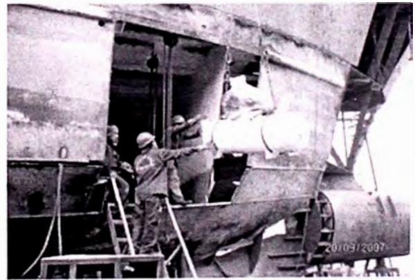
VISTA DEL INGRESO DE UN COMPRESOR DE AIRE
