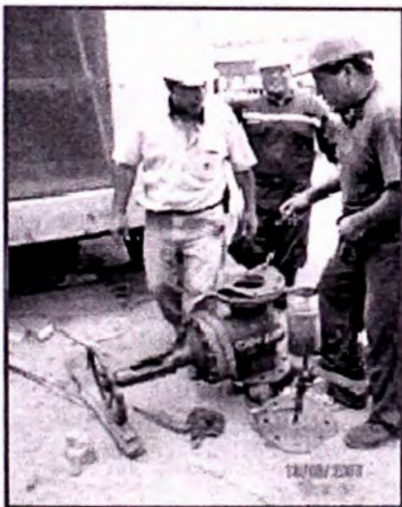
PRUEBA HIDROSTATICA DE VÁLVULAS
