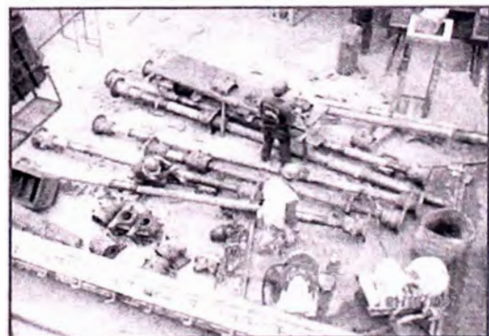
DESMONTAJE Y RETIRO DE EJES Y CHUMACERAS
