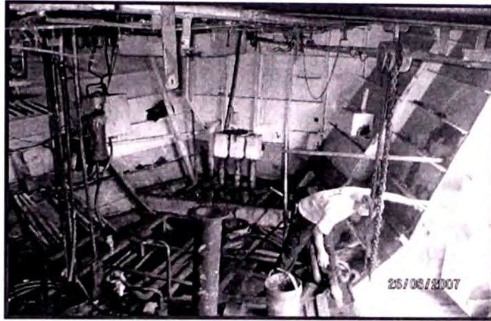
Figura 3.8: Retiro de los equipos de máquina principal, equipos.
