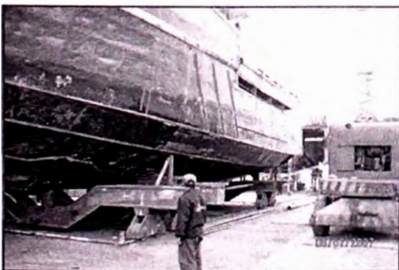
MANIOBRA DE SEPARACION DEL BLOQUE DE PROA
