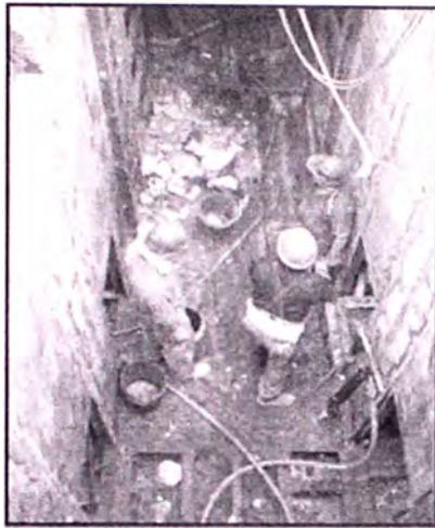
USO DE MARTILLOS PNEUMÁTICOS
