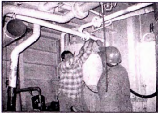
DES MONTAJE DE LA LÍNEA DE ACHIQUE
