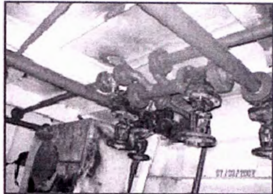
PRUEBA DE LAS LINEAS Y RAMALES DE ACHIQUE
