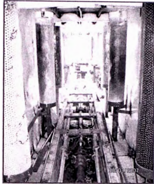
VISTA DEL SISTEMA DE PROPULSIÓN INSTALADO
