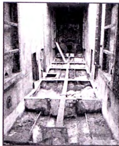
RETIRO Y ROTURA DEL CONCRETO
