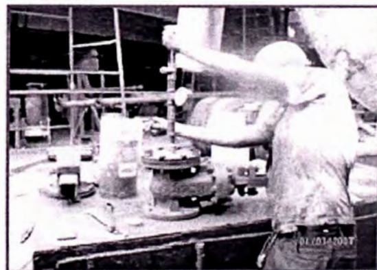
PRUEBA HIDROSTATICA DE VÁLVULAS
