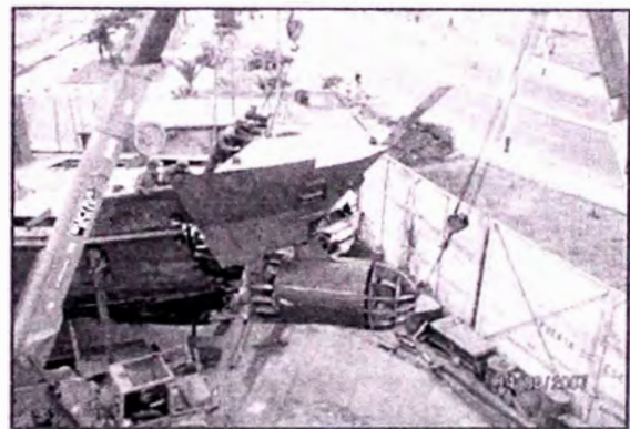
ERECCION DEL MODULO DE FIGUE DE PROA Y BULBO.
