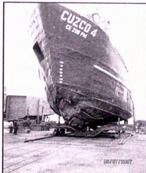
CORTE Y SEPARACION DEL BLOQUE DE PROA
