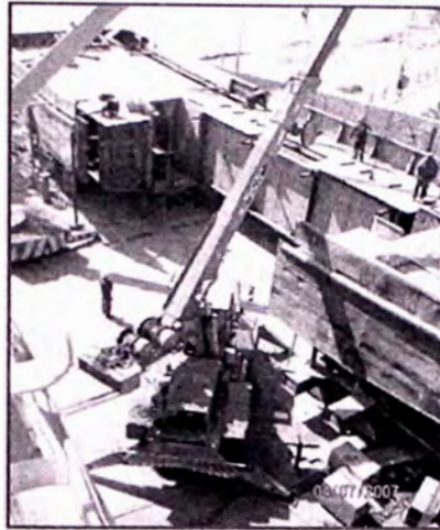
ERECCION DEL MODULO LADO BABOR.
