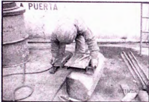
FABRICACION DE BASE DE BOMBA ACHIQUE
