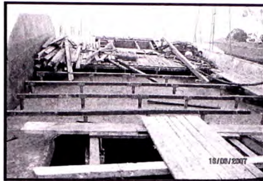
Figura 3.13: Retiro del enjaretado y de sus bases.
