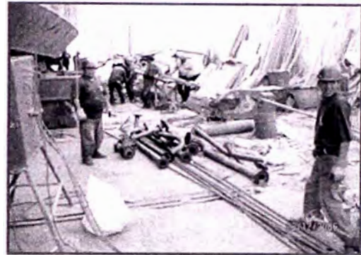
RETIRO DE LAS TUBERÍAS DE LOS SISTEMAS
