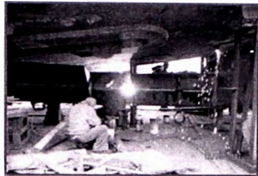
SOLDADURA DEL KEEL COOLER.
