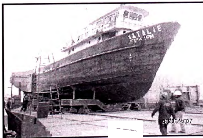
CORTE Y SEPARACION DE LOS BLOQUES DE PROA/POPA
