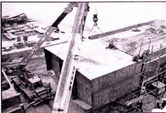
ERECCION DEL MODULO COMPLETO.
