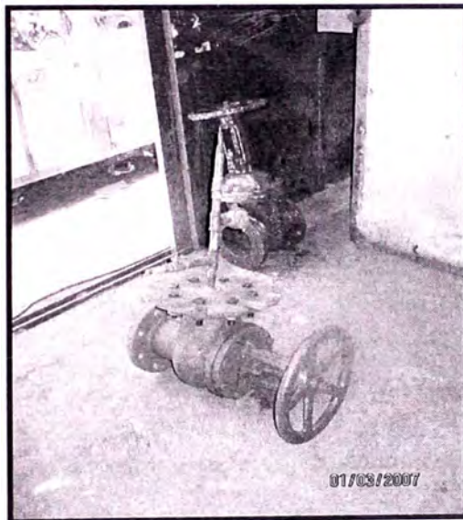
Figura 3.11: Prueba hidrostática de las válvulas desmontadas.
