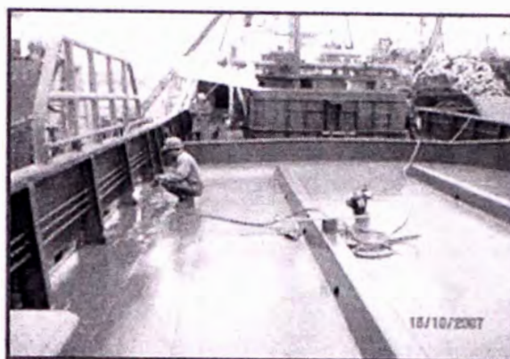
PINTADO DE LA CUBIERTA PRINCIPAL
