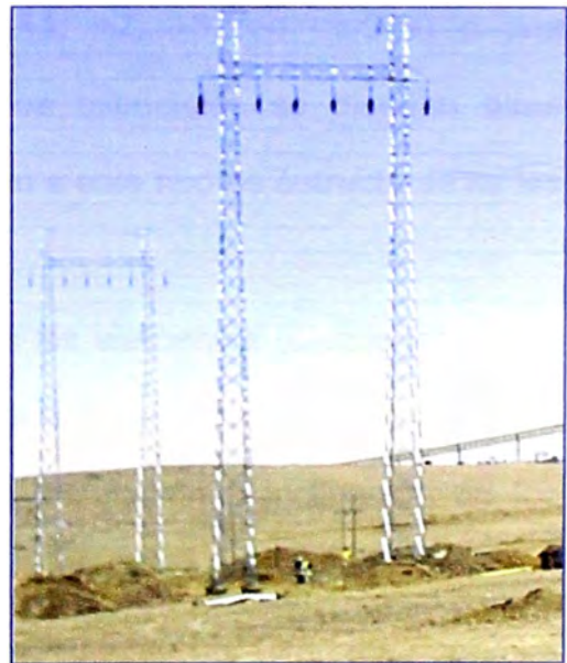
Figura 3.6: Estructura de abatimiento
