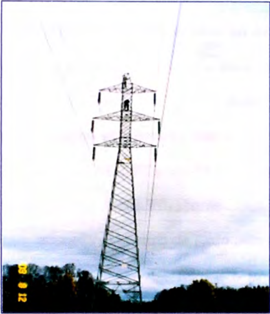
Figura 3.3: Estructura de suspensión
