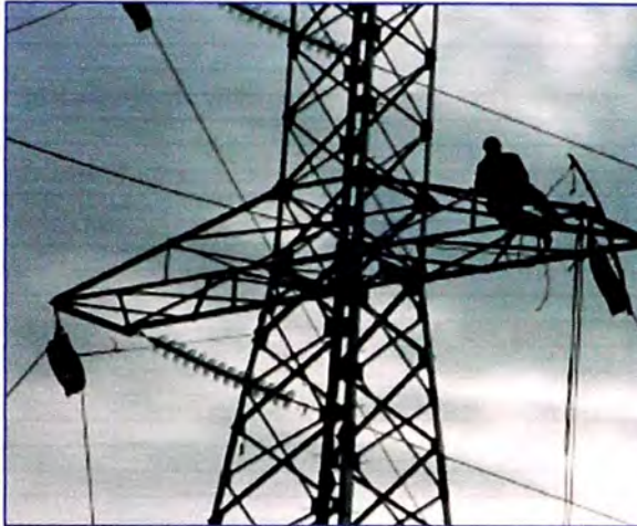
Figura 3.7: Montaje de aisladores
