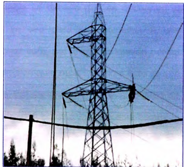
Figura 3.2: Estructura de simple terna
