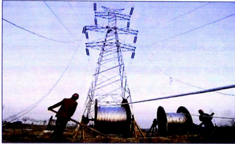
Figura 3.9: Tendido de línea de transmisión
