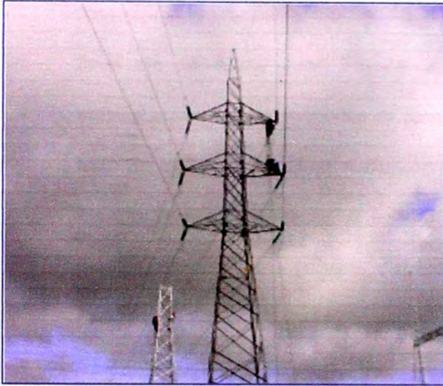
Figura 3.1: Estructura de doble terna
