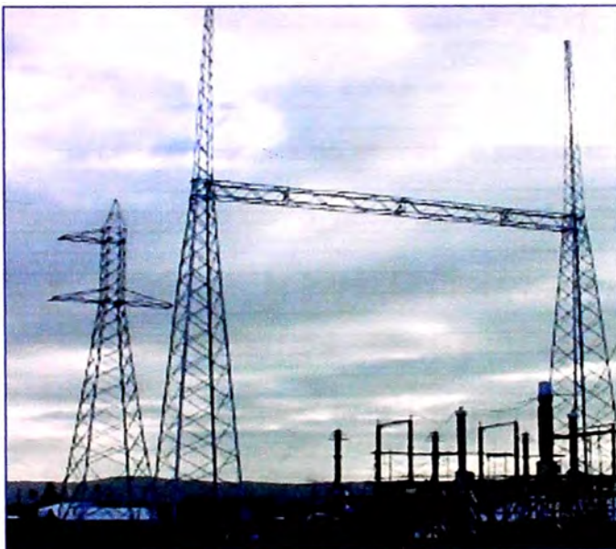
Figura 3.5: Estructura de llegada
