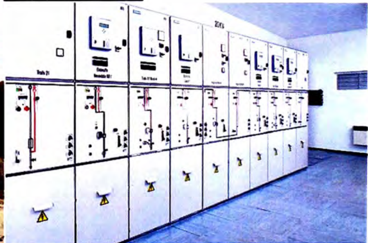
Celdas NXPLUS C 20 kV (ejemplo)
