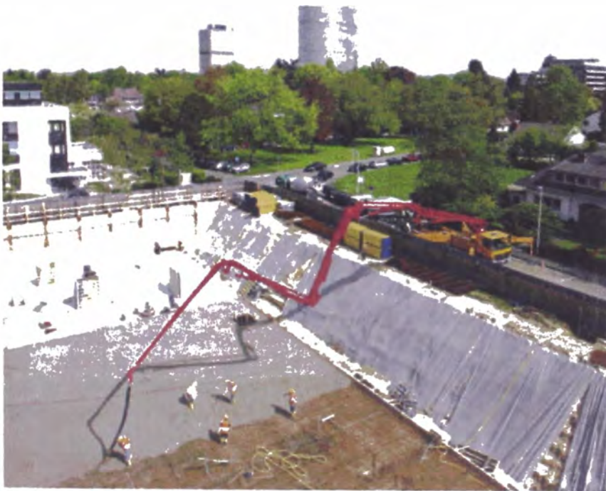
Fig. 1: Autobomba Putzmeister M 42-5 en Bonn
