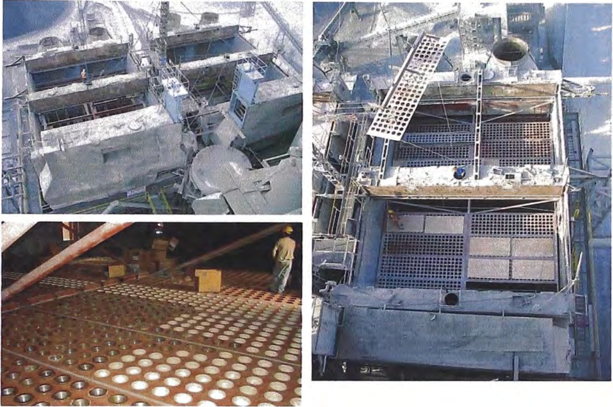
Fig. 5.2 Montaje del Filtro de Mangas
