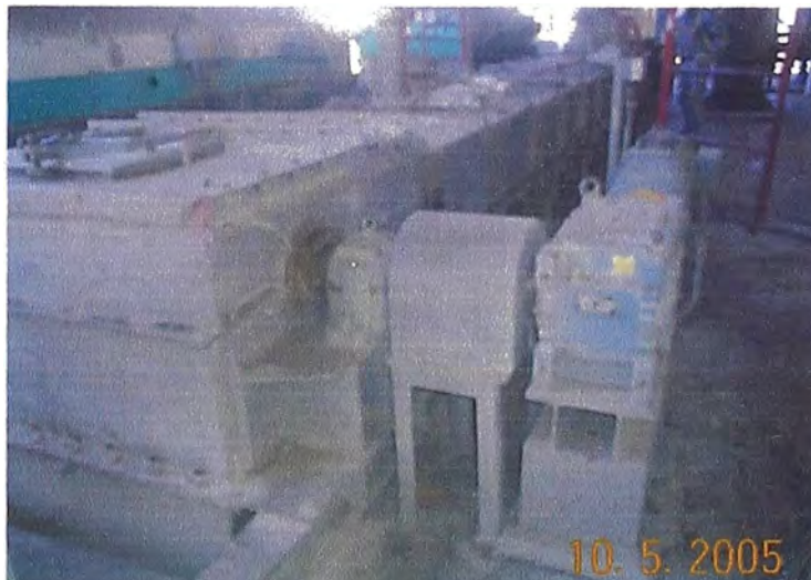
Fig. 5.3 Montaje del transportador de cadena
