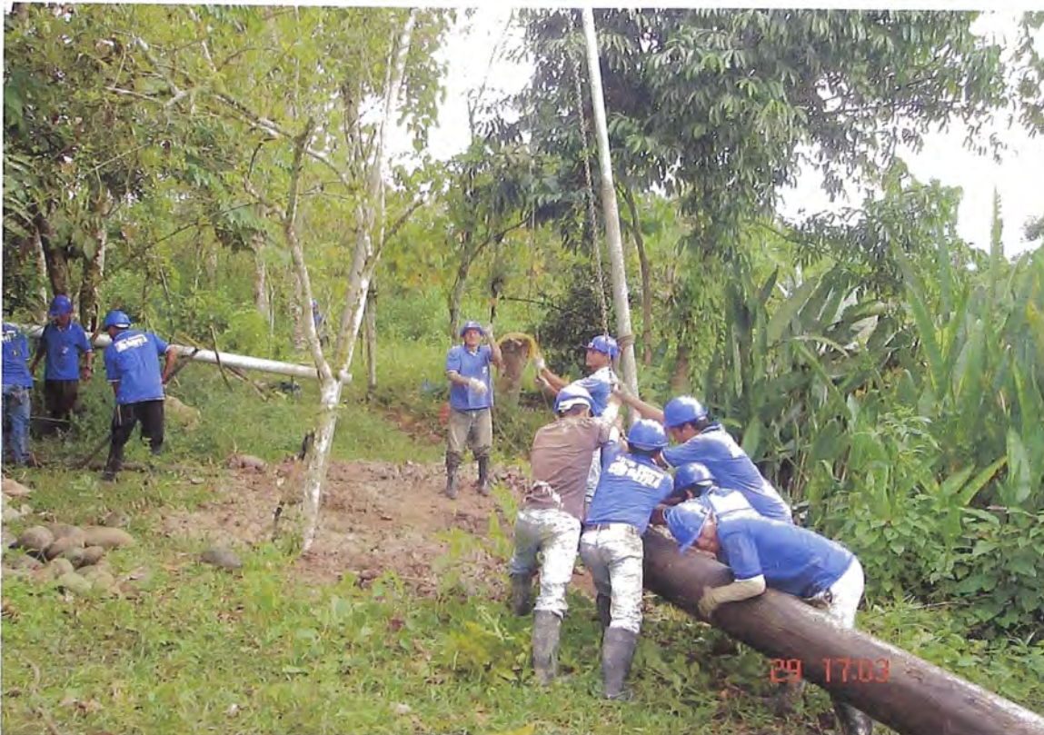
Fig. 5.1: Izamiento de Poste de madera
