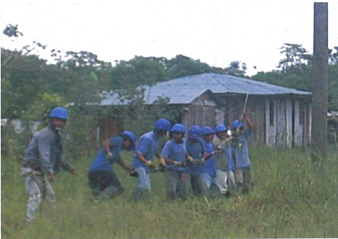
Fig. 5.2: Tendido de Conductor de 50mm 2
