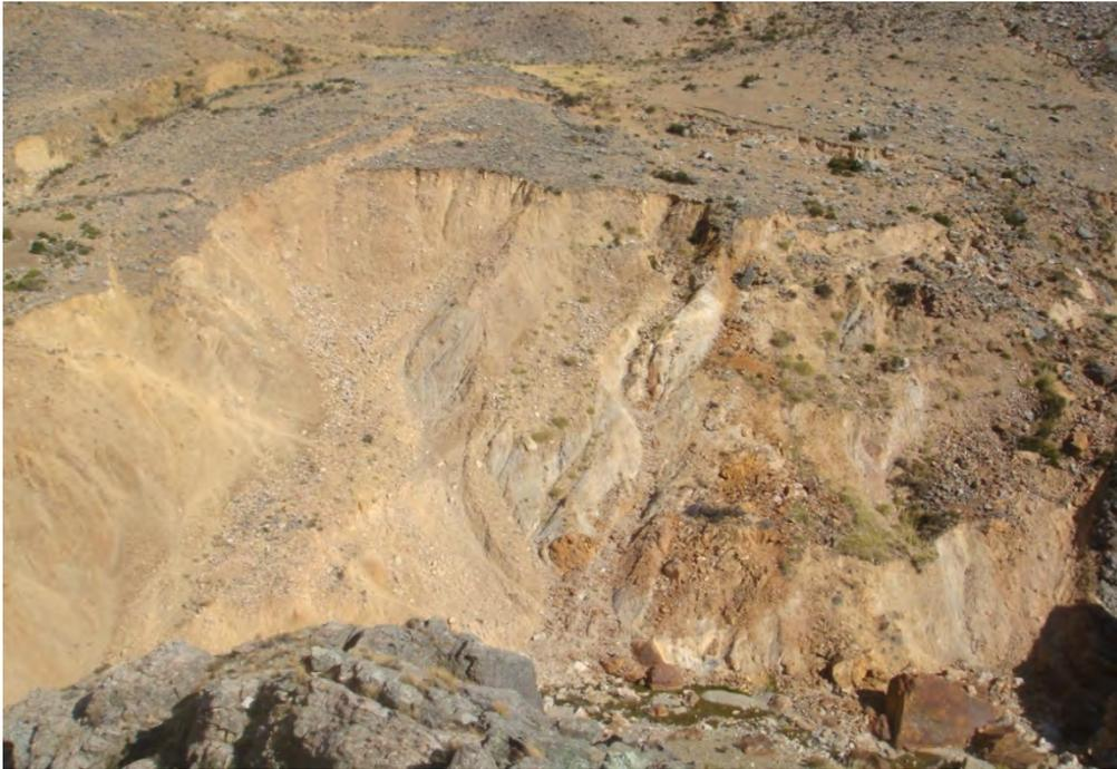
**Foto N°21:** vista hacia el SO, derrumbe producto del socavamiento o erosión fluvial por el río Tambo. Pie del talud estribo izquierdo.
