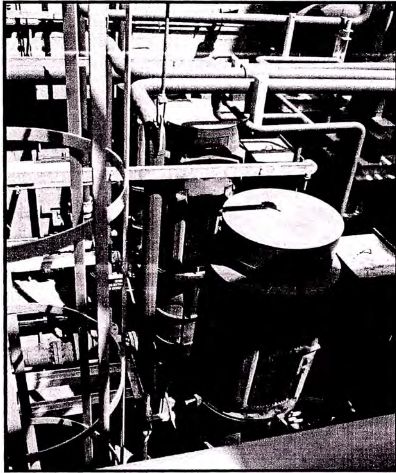
Figura. 2.32. Bombas de extracción de condensados
