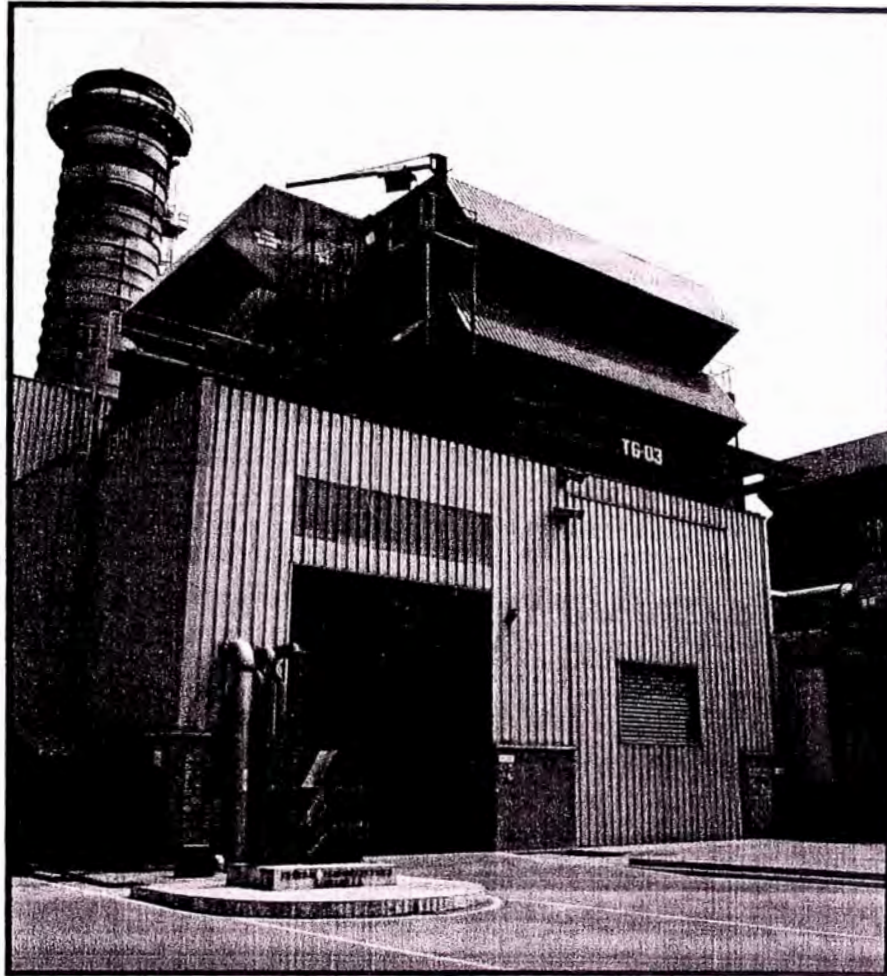
Figura. 2.3. Casa de Turbinas de Gas
