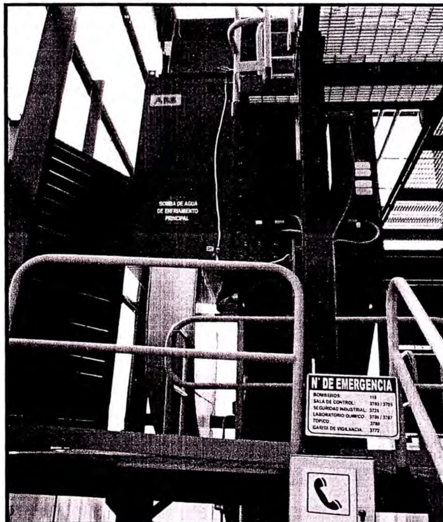
Figura. 2.37. Bombas del Sistema de refrigeración principal
