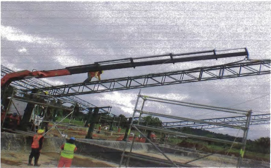
Fig. 6.3 Montaje de Estructura
