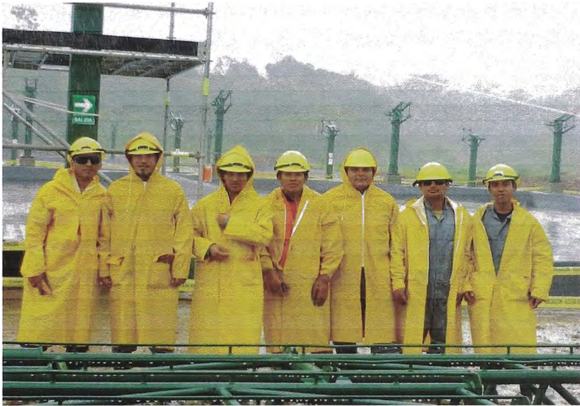
Fig 3.4 Uso de EPP en el montaje.
