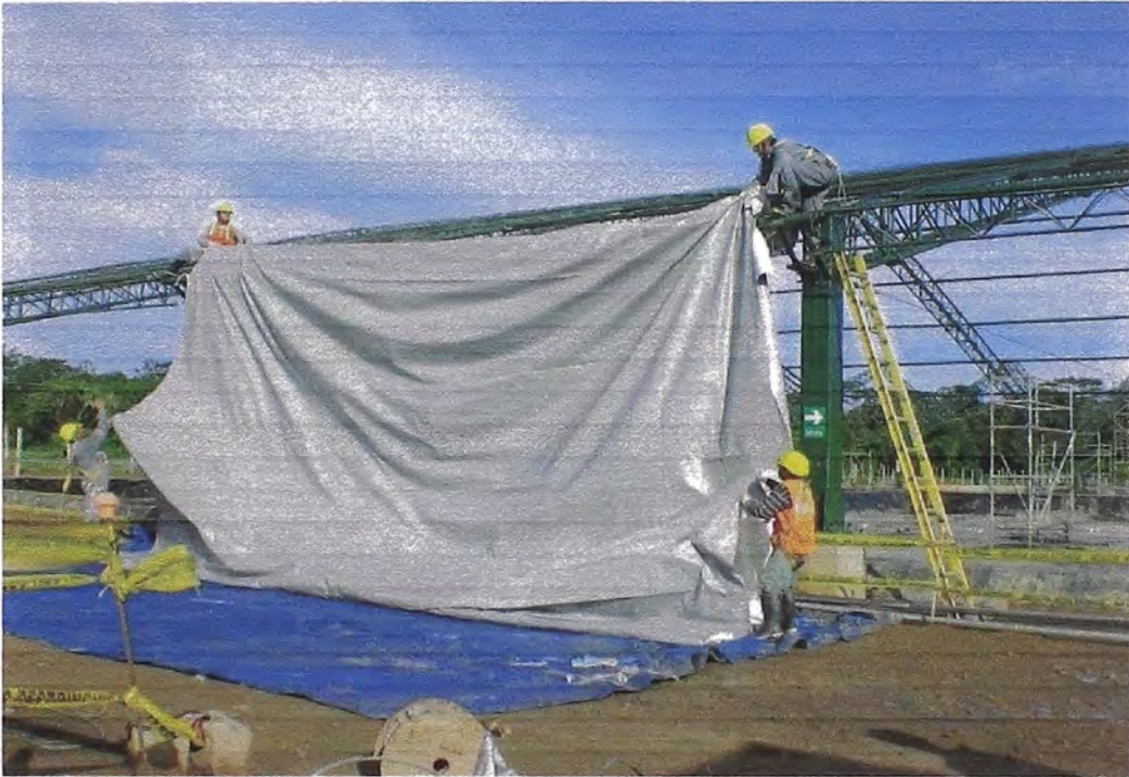
Fig 7.1 Extendiendo lona flexible.
