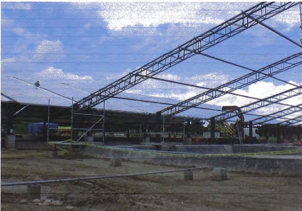
Fig 7.2 Techo del almacén con flexilona
