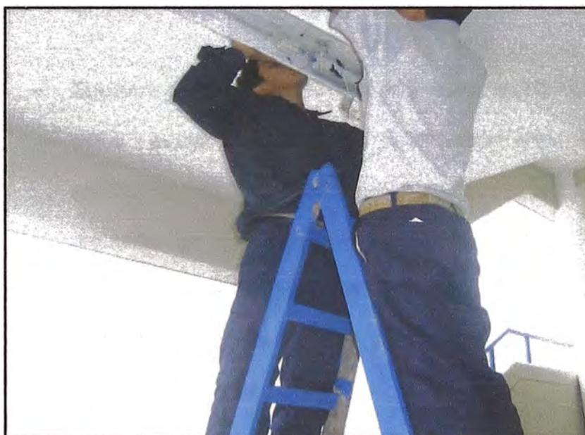
**Figura N° 4.10- Reemplazo de unidades de iluminación**
