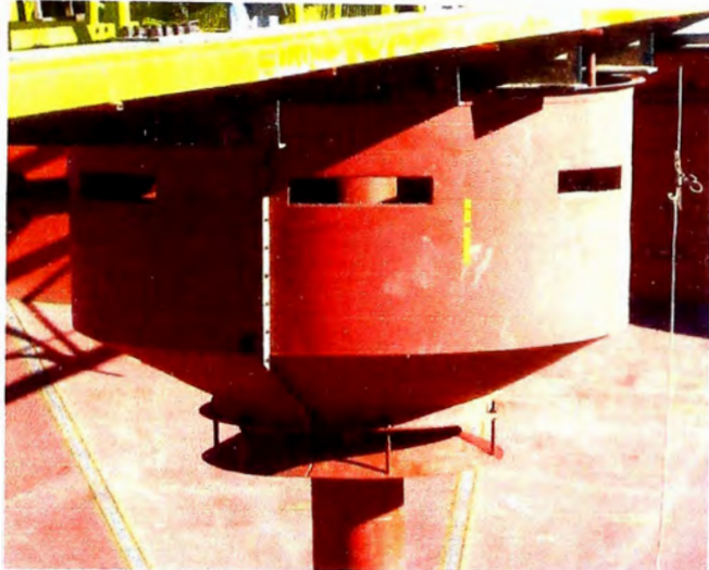
Figura 3.7: Montaje del Tanque de alimentación (Feedwell)
