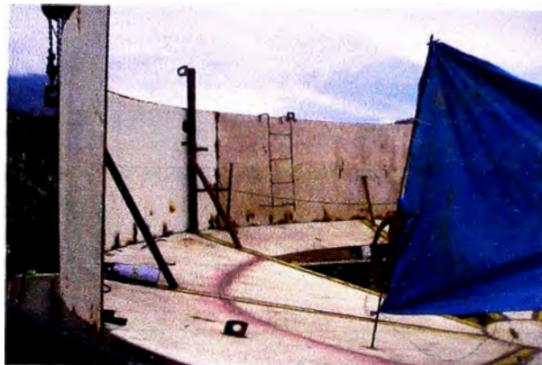
Figura 3.3: Montaje de las paredes del espesador
