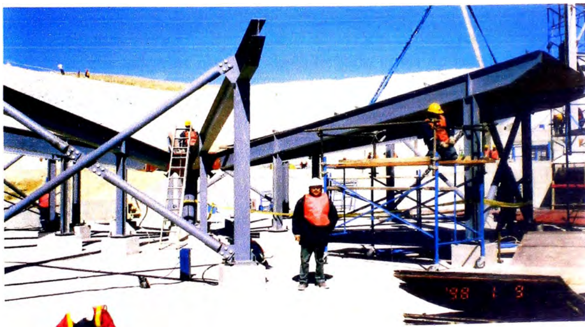
Figura 3.1: Montaje de la estructura de soporte
