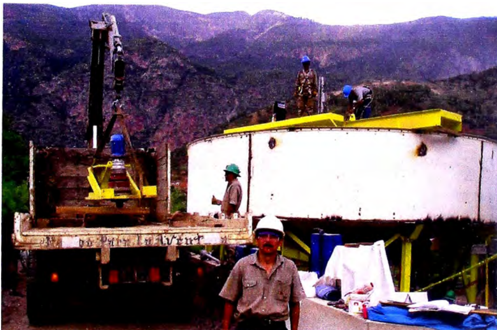
Figura 3.6: Montaje del rake lift
