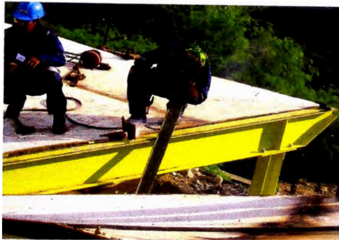
Figura 3.2: Montaje del fondo del espesador
