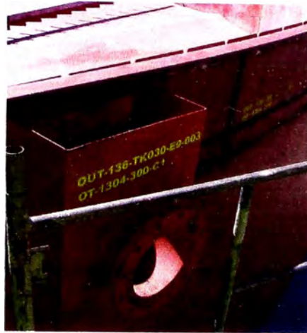
Figura 3.5: Montaje de la caja de rebose
