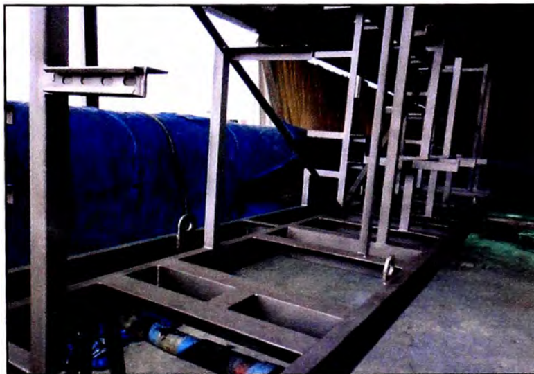
Fig.3.2.Estructura para equipo Osmosis Inversa para SMCV, después de granallar.
