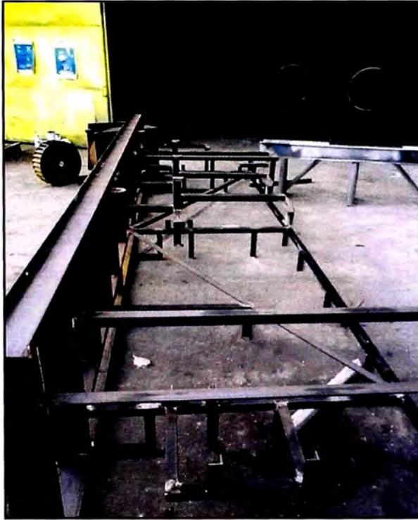
Fig.3.1.Estructura para equipo Osmosis Inversa para SMCV, antes de granallar.
