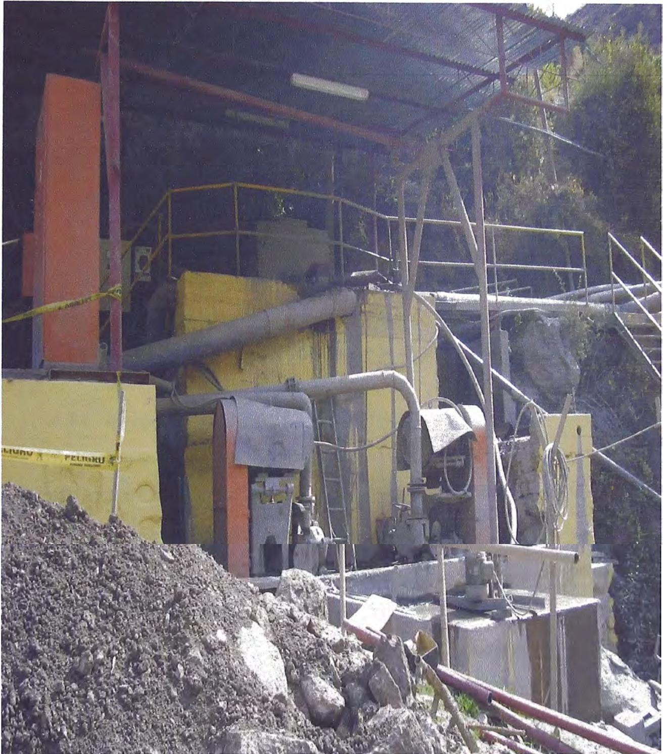
**Fig. N° 3.5 Estación de bombeo de relaves, bomba wilfley 5K**
