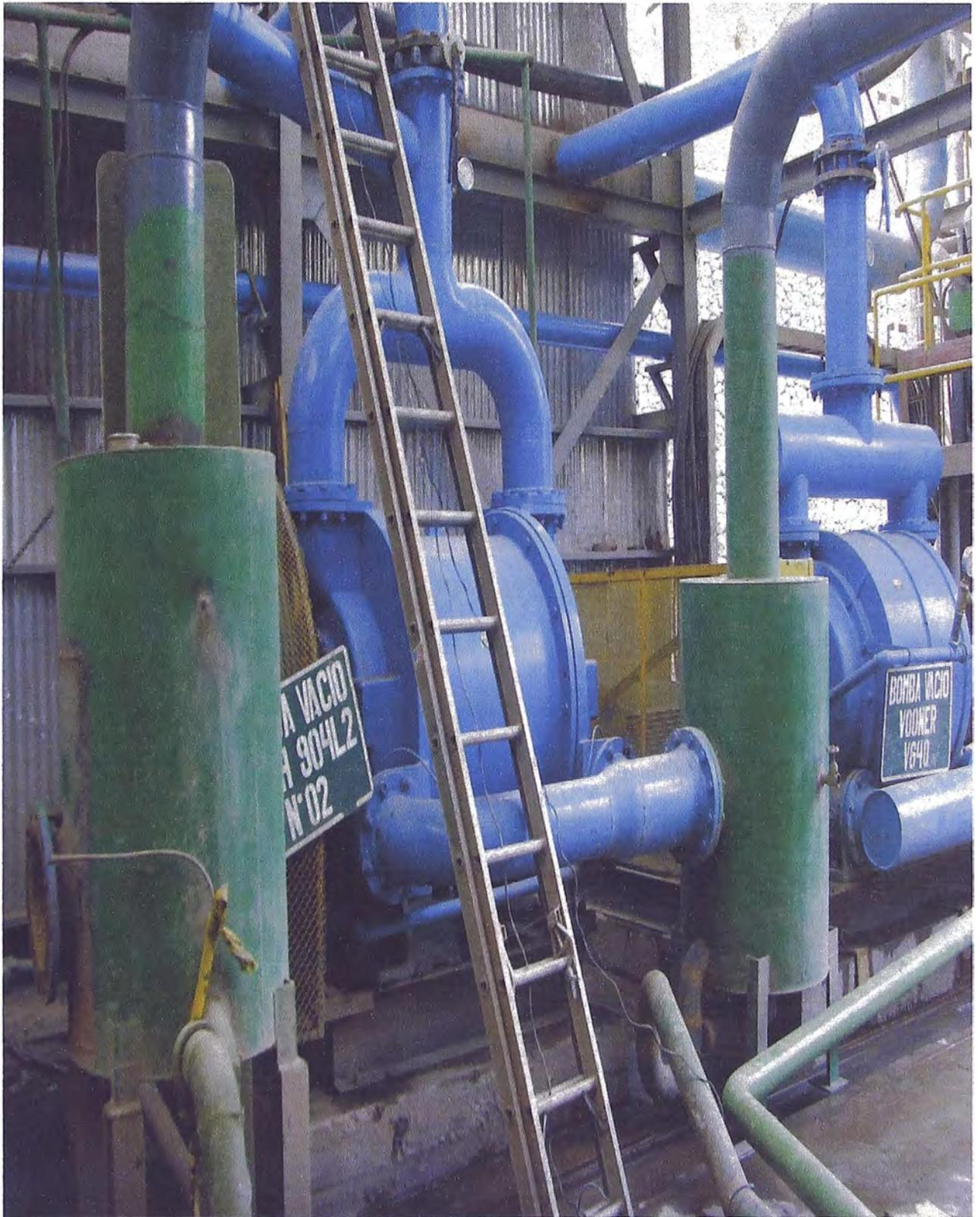
**Fig. N° 3.6 Bomba de Vacío Voerner Vg. 40 filtro de relaves**
