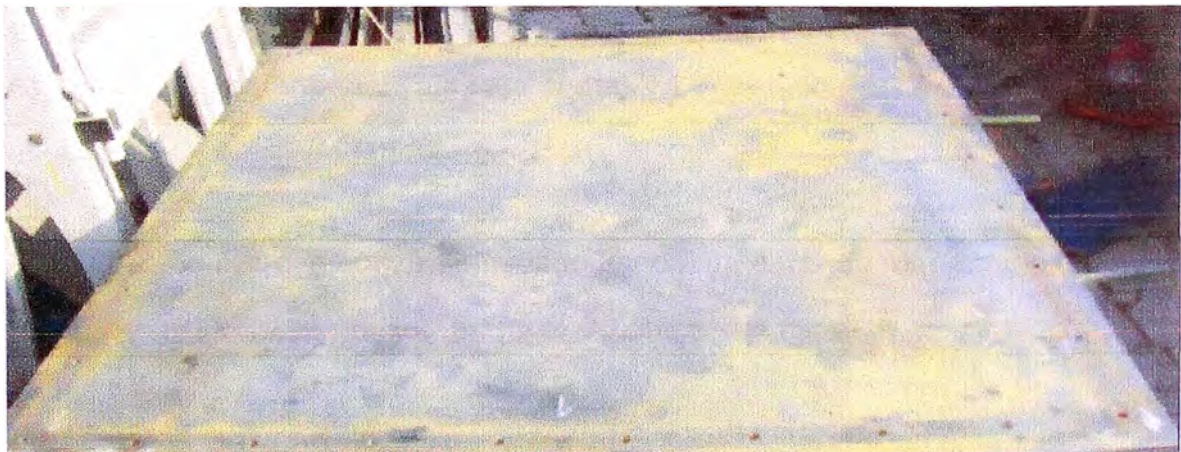
Figura N°- 4.1 : Hoja de compuerta con agujeros perforados para el sello de hermeticidad
