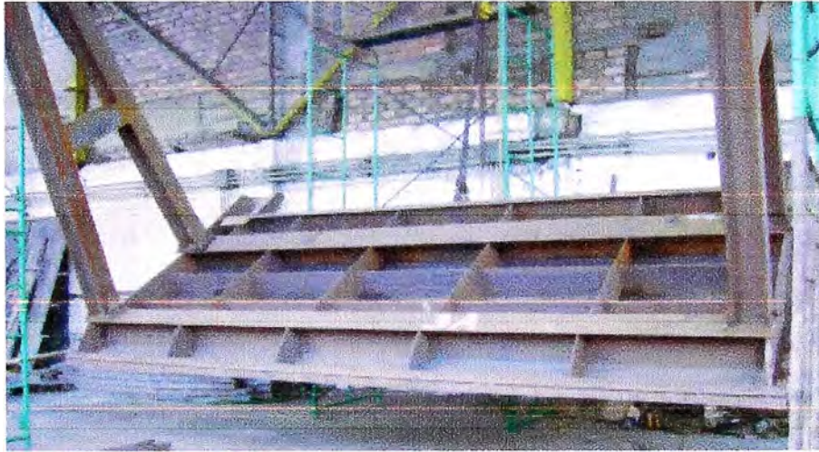
Figura N°- 2.6 : Fabricación de compuerta radial
