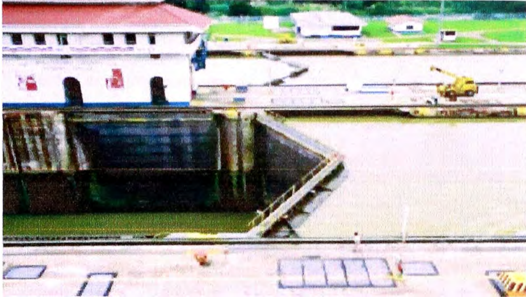
Figura N°- 2.10 : COMPUERTA TIPO ESCLUSA
