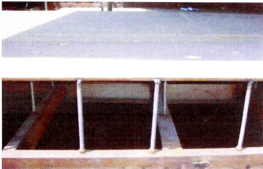
Figura N°- 4.2 : Hoja de compuerta en mesa de trabajo
