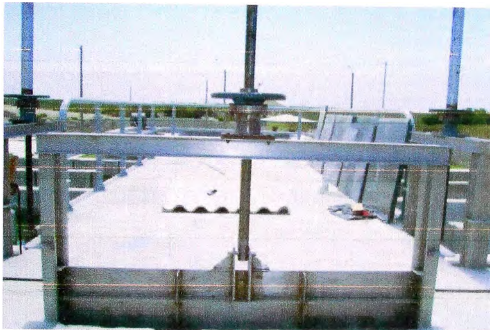
Figura N°- 2.4 : Compuerta tipo tarjeta de accionamiento por volante SUB SISTEMA DE PRODUCCIÓN DE AGUA SUPERFICIAL – PIURA
