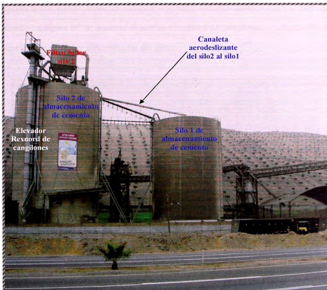
Figura N° 5 – Silos de almacenamiento de cemento
