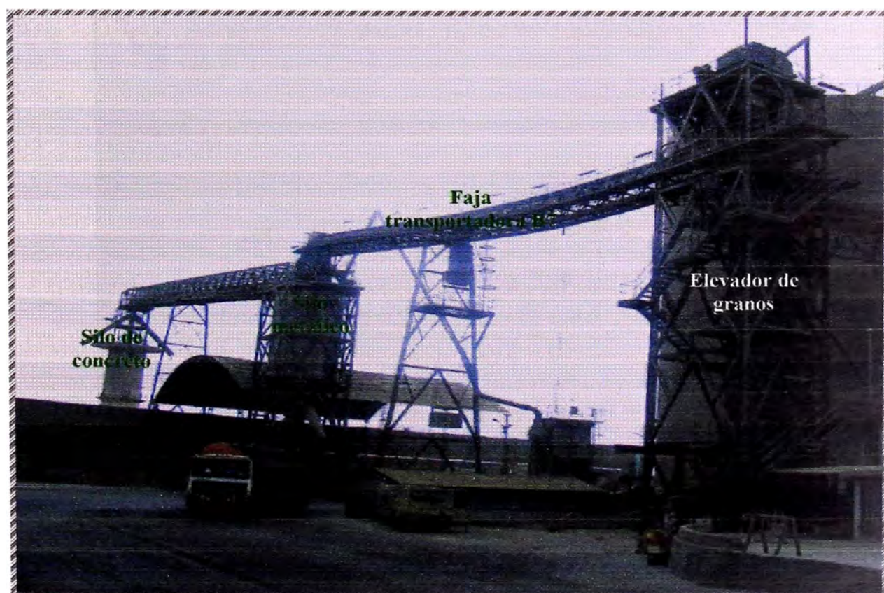
Figura N° 21 – Descarga de granos
