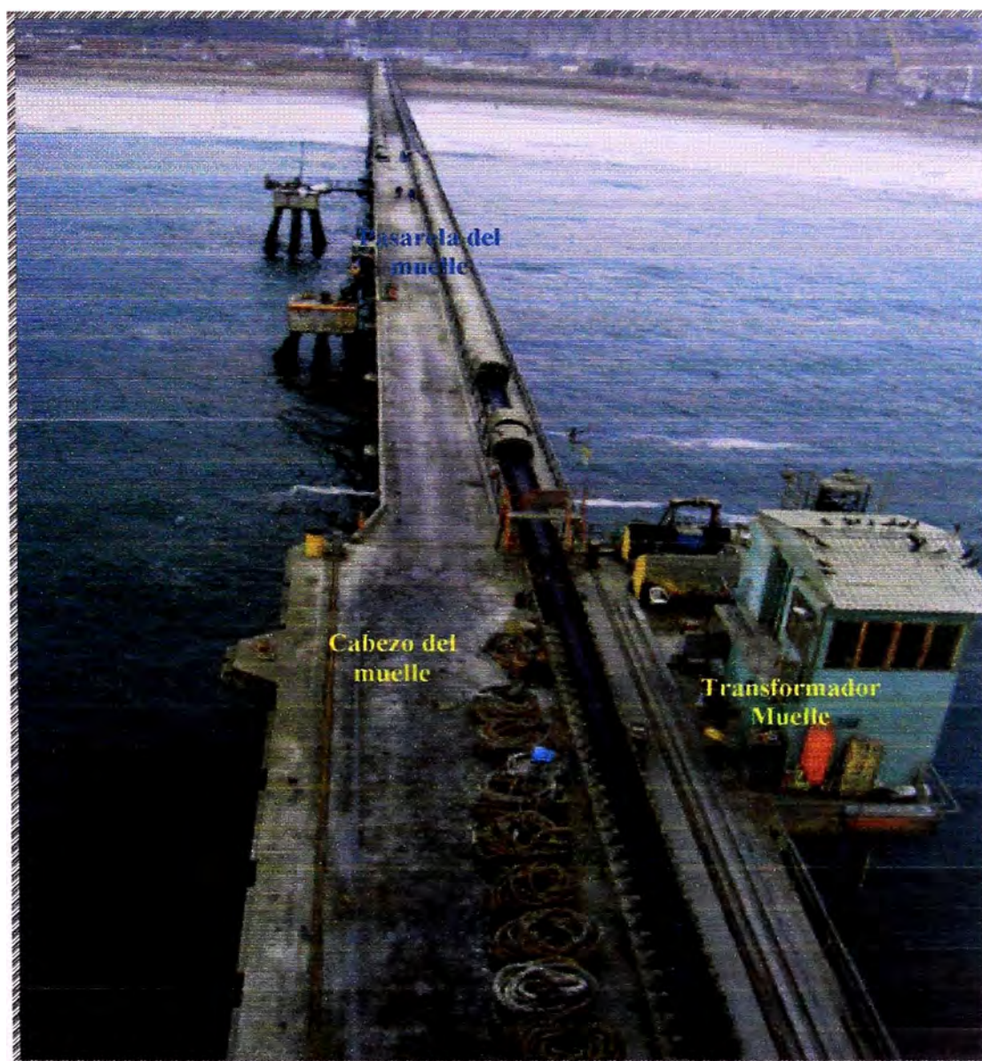
Figura N° 27 – Pasarela del muelle conchán
