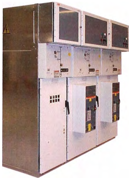
Fig. 2.9 Celdas de Media Tensión
