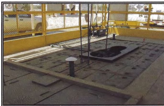
Figura N° 2.8 Tanque horizontal ubicado en el subsuelo
