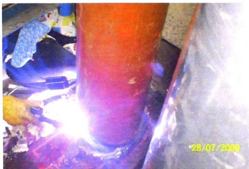
Figura 3.1 Trabajos de Soldadura
