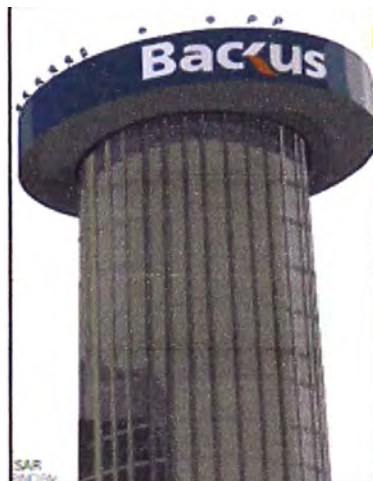
Figura 2.2 Tanque de Agua
